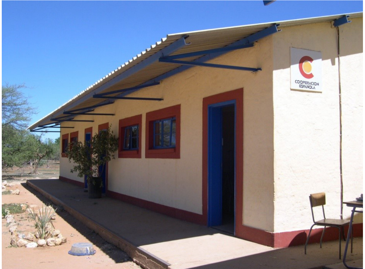
Escuela Reasentamiento Reina Sofía
