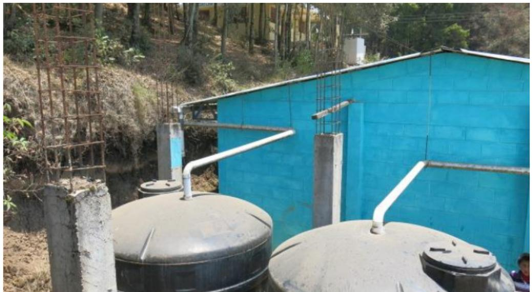
Una vez concluida la instalación, se procederá a hacer una serie de pruebas finales: prueba de corrimiento de agua en el techo y el canal, verificar que no haya goteras ni filtraciones, prueba de conducción de agua en la tubería que interconecta con el depósito de agua, y prueba de estanqueidad el agua. Para ésta, se colocará una marca y se registrará el descenso del agua después de 72 horas. Este descenso no puede ser superior al 1/2 del volumen total del agua almacenada.
