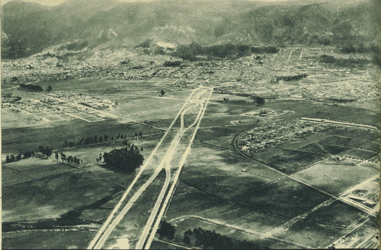
De arriba a abajo: Tres vistas aéreas de la Avenida de las Américas, que se construye en Bogotá. La primera y la segunda
