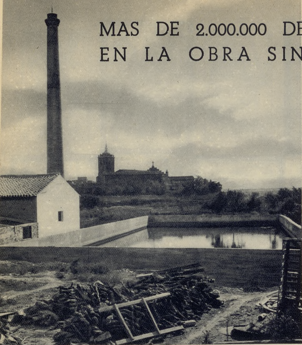
Una de las ciento cincuenta y dos bodegas cooperativas de la Obra Sindical de Cooperación. Fábrica de alcohol centrífugo, de Cimborena (Navarra).
