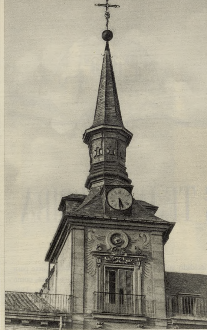
Casa de la Panadería (Plaza Mayor).
