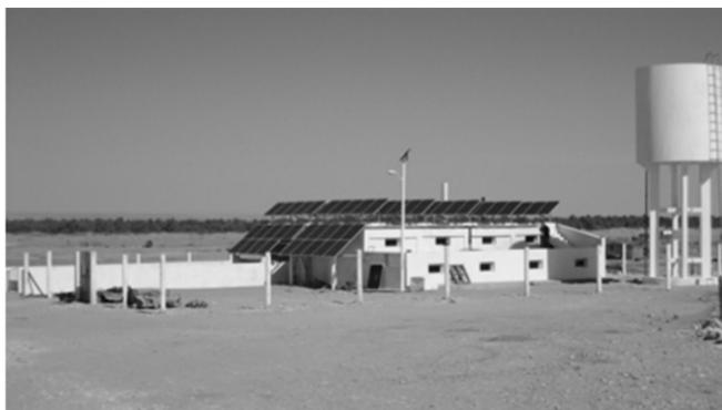
IMAGEM 3. PLANTA DE DESSALINIZAÇÃO FOTOVOLTAICA DE KSAR GHILÈNE (FONTE: ITC)
