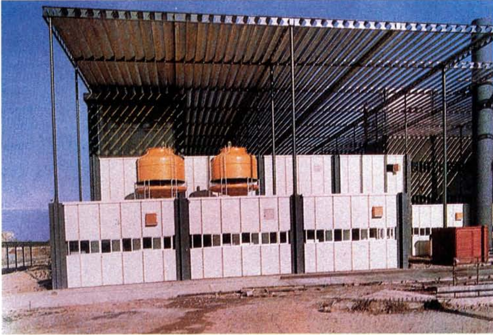
Hospital de Orán, Estudio Llauró y Ürgell y asociados/Hampton- Ramírez, 1969/76. Sistemas modulados adaptados a condiciones climáticas rigurosas gracias a la solución de cubierta
