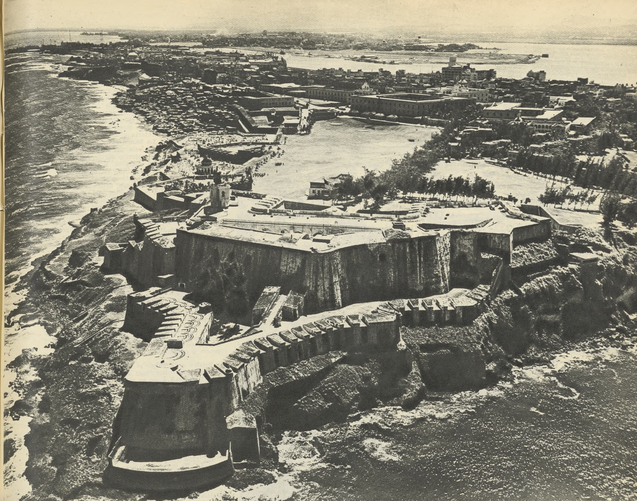
Castillo de San Felipe de El Morro. La majestuosa fortaleza corona la entrada del puerto de San Juan. Pese a su antigüedad, se conserva en magníficas condiciones, resistiendo no sólo la furia del mar y del tiempo, sino los proyectiles de los cañones enemigos. Considerado como el Gibraltar del Nuevo Mundo, todavía durante la guerra hispano-americana de 1898, sus murallas defendieron el ataque de la flota yanqui del almirante Sampson.
