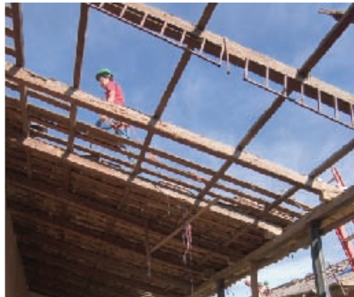
Mercado Municipal en proceso de restauración
