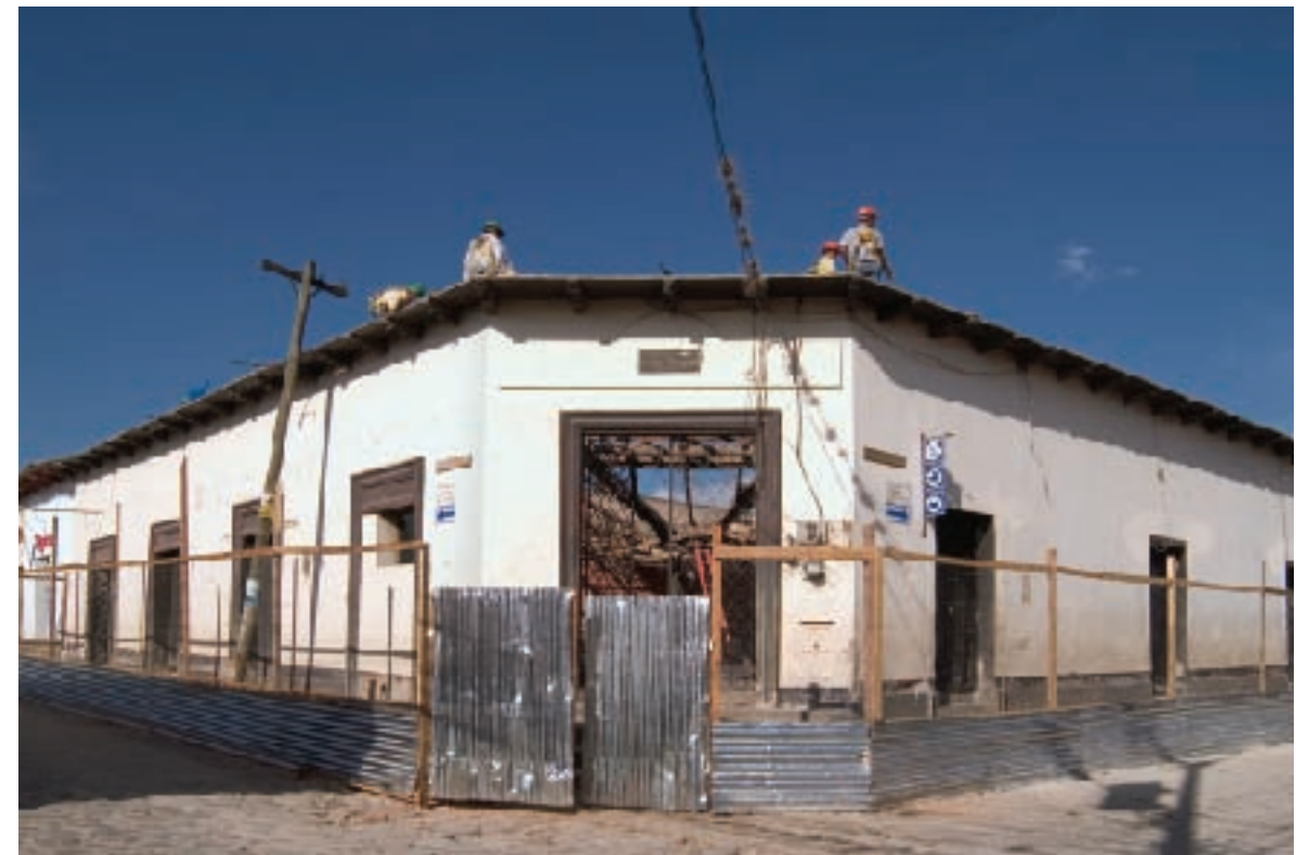
Alumnos de la Escuela Taller de Gracias trabajando en el proceso de restauración del Mercado Municipal
