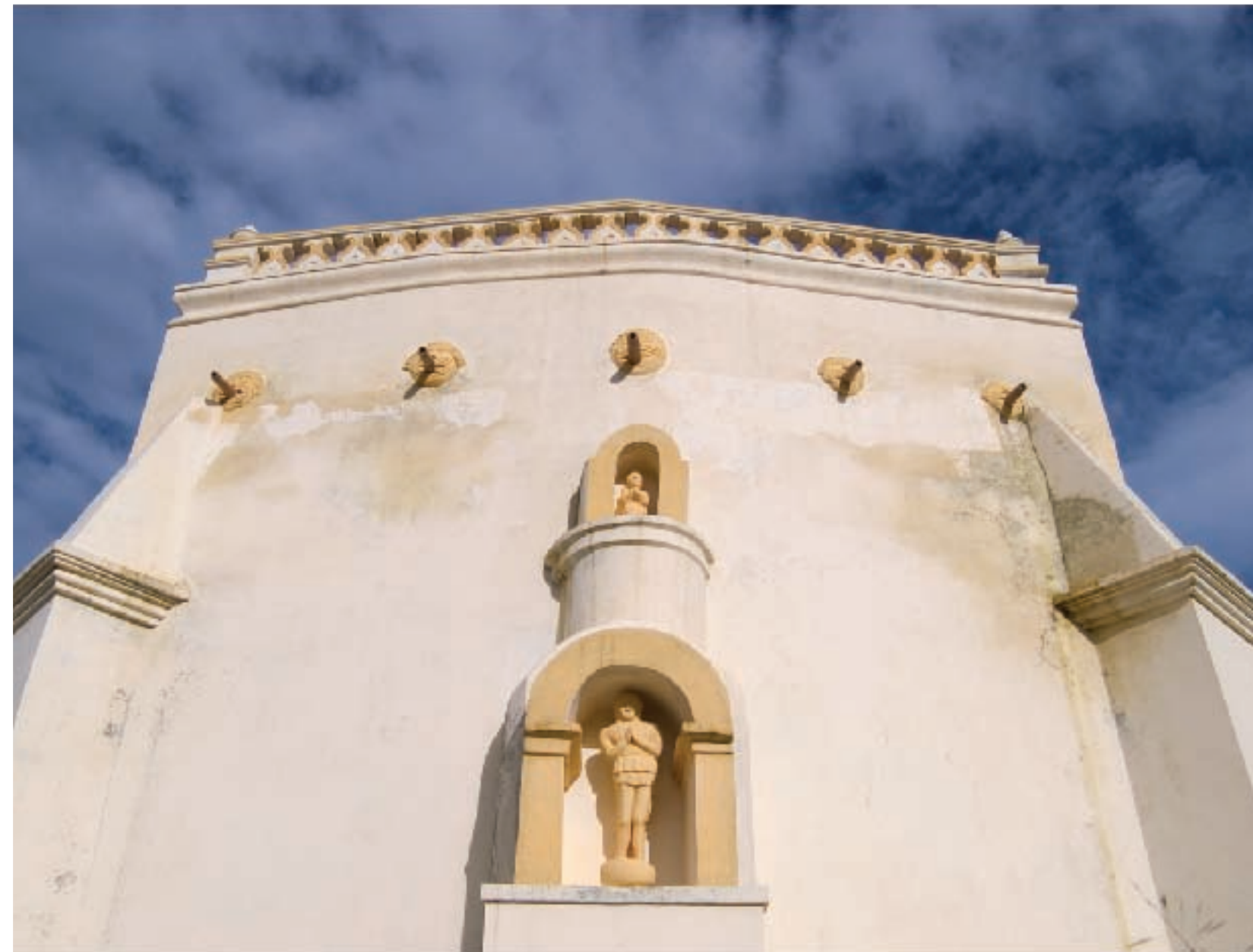
Fachada Este de la iglesia de San Manuel de Colohete
