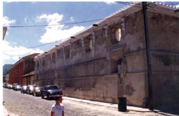
Consolidación e integración de muros perimetrales, claustro norponiente, 2003-2005
