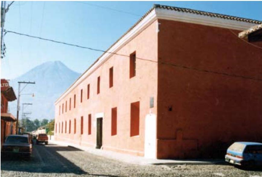
Integración de la fachada de los claustros norponiente y suroriental, 1992-2000
