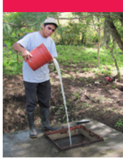
Cloración de sistema
