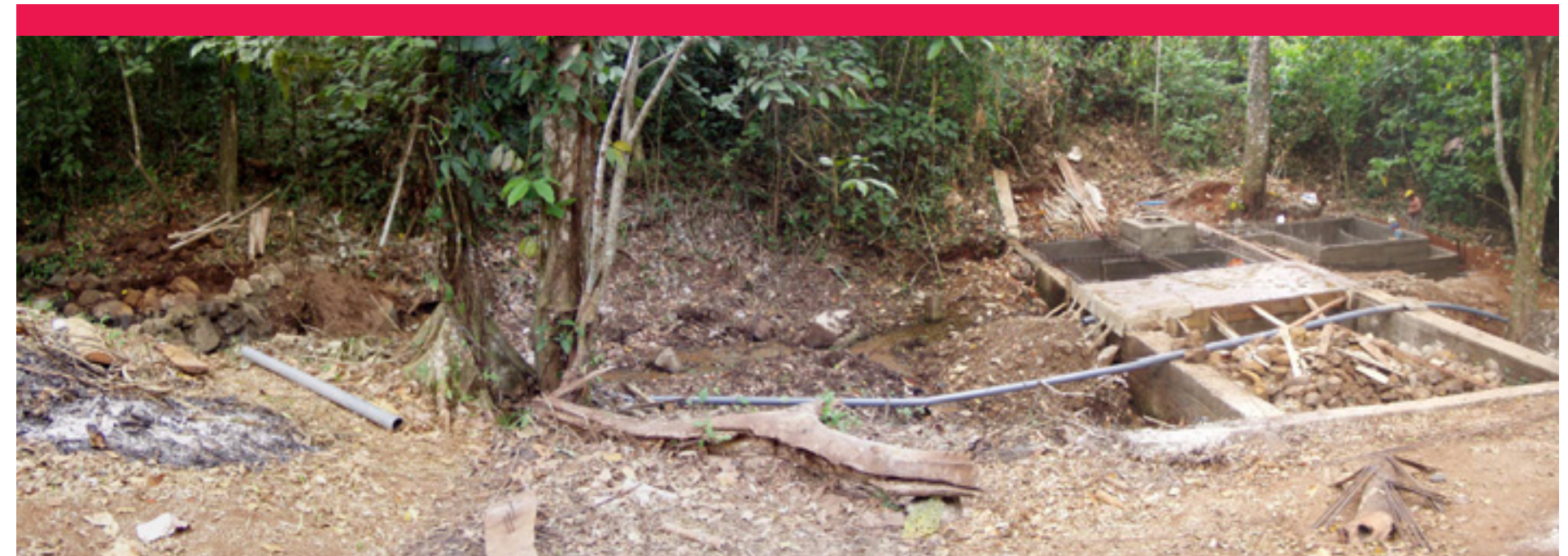
Sistema de agua potable y saneamiento proyecto Araucaria Río San Juan
