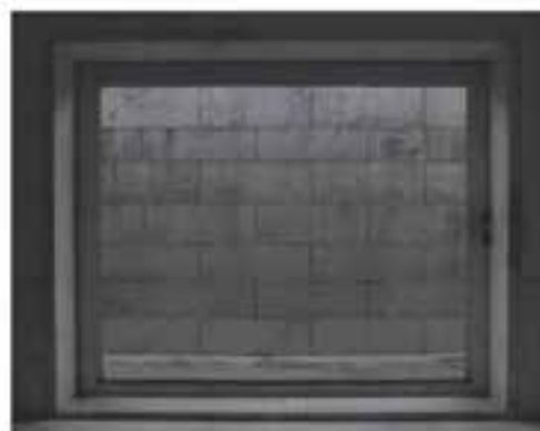
Vista desde el interior del muro de piedra que delimita las terrazas superiores del edificio CGAC.
