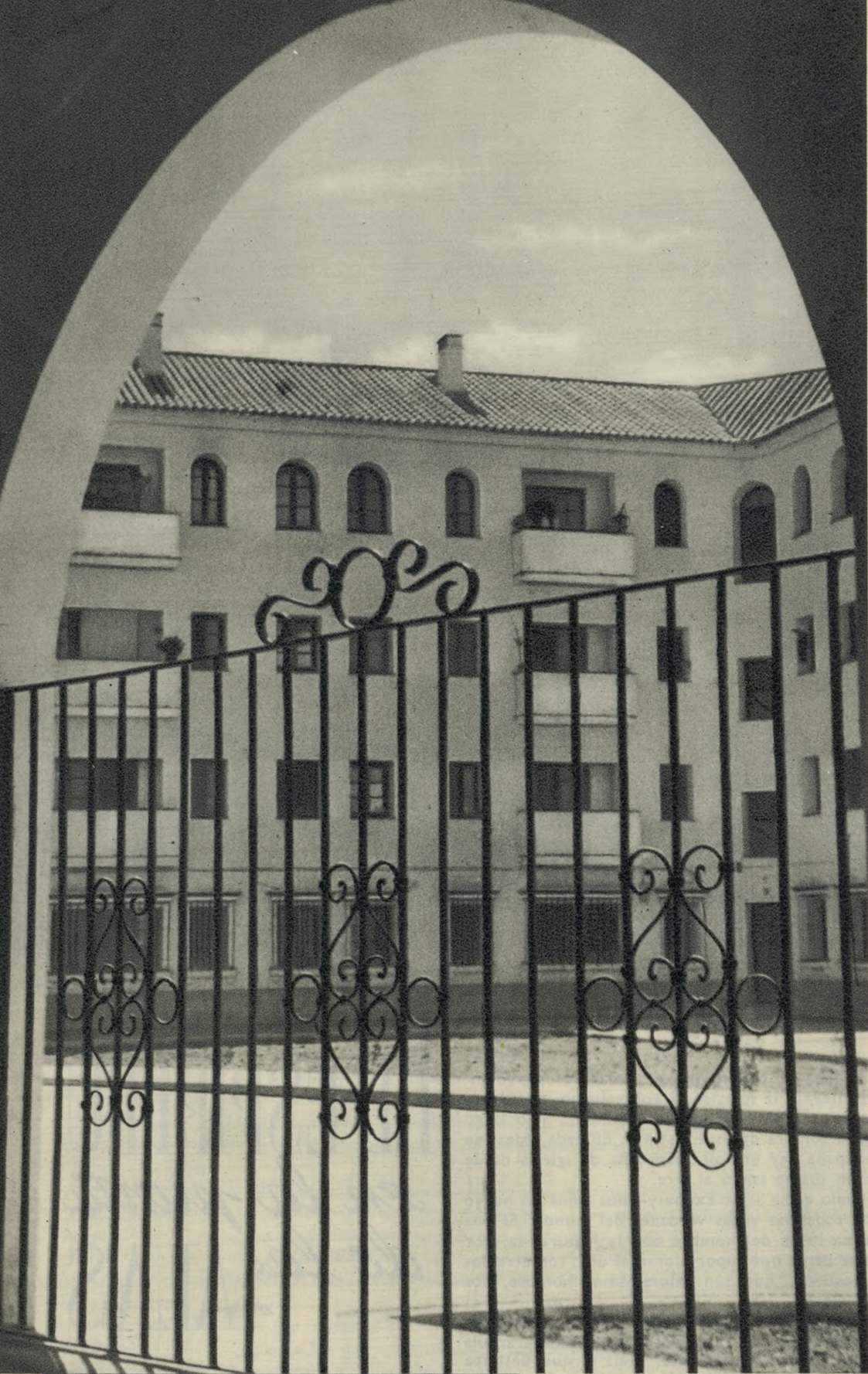
Arriba: Bloque de 40 viviendas construido en Sevilla. Abajo: Grupo de 72 viviendas construido en Almorchón.
