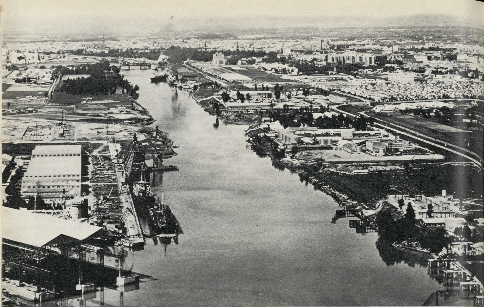
Instalaciones industriales en la dársena de Sevilla
