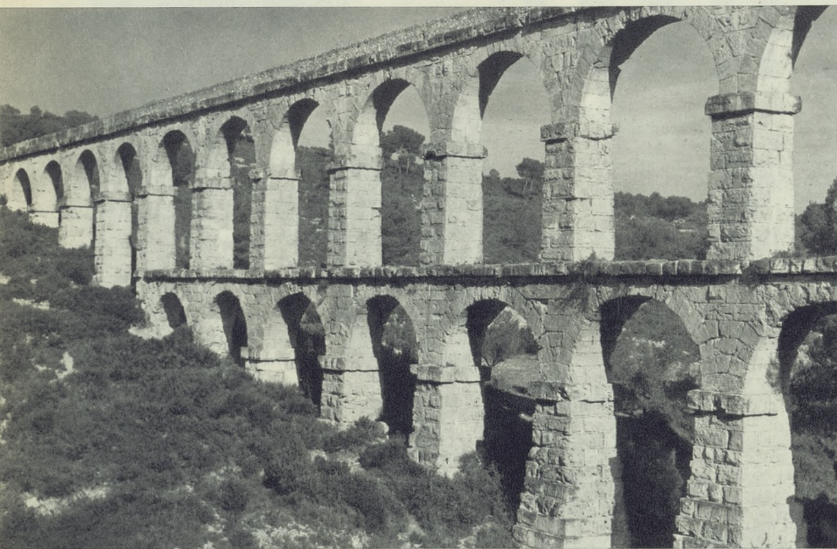
Acueducto romano de Tarragona.
