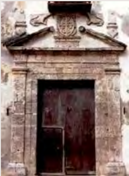
Portada del claustro de Santo Domingo, antes y después de la restauración.
