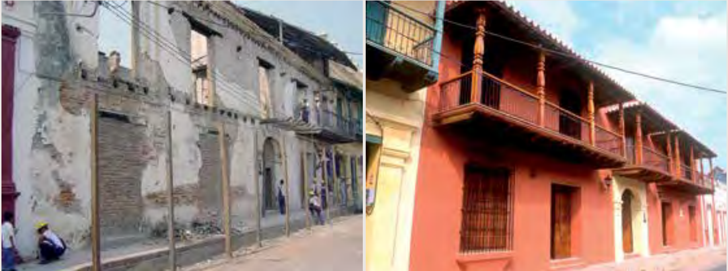
Casa del Cabildo, antes y después de la restauración.
