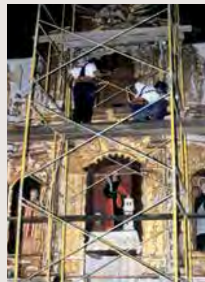
Restauración del retablo mayor de la iglesia de Santa Bárbara.
