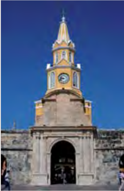
Portada de la Boca del Puente, después de la restauración.
