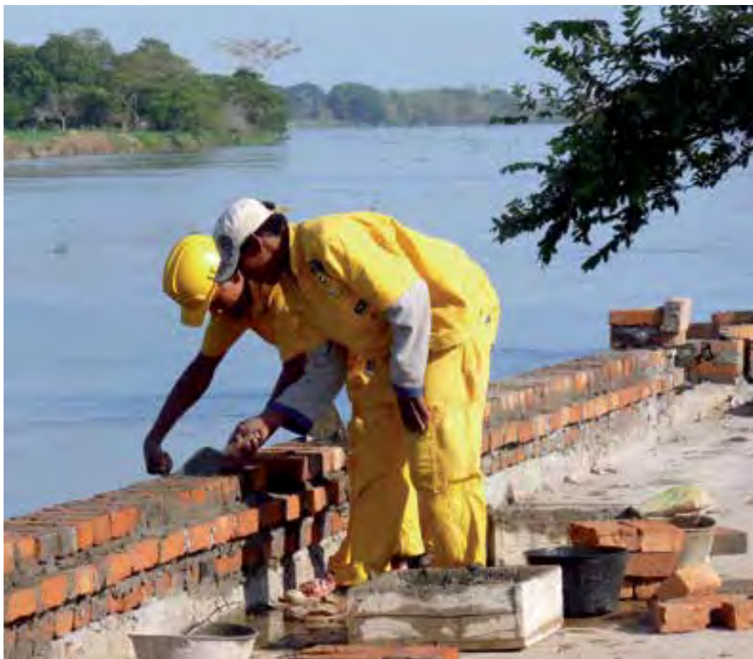
Aprendices levantando un muro de contención a orillas del río Magdalena.
