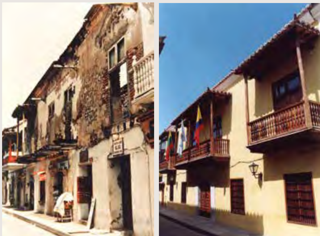
Fachada de la antigua Casa de la Moneda, antes y después de la restauración.
