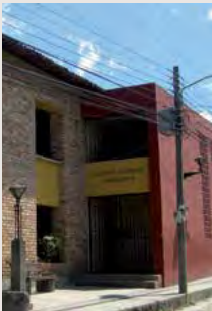
Centro Comunal, barrio Yanaconas.
