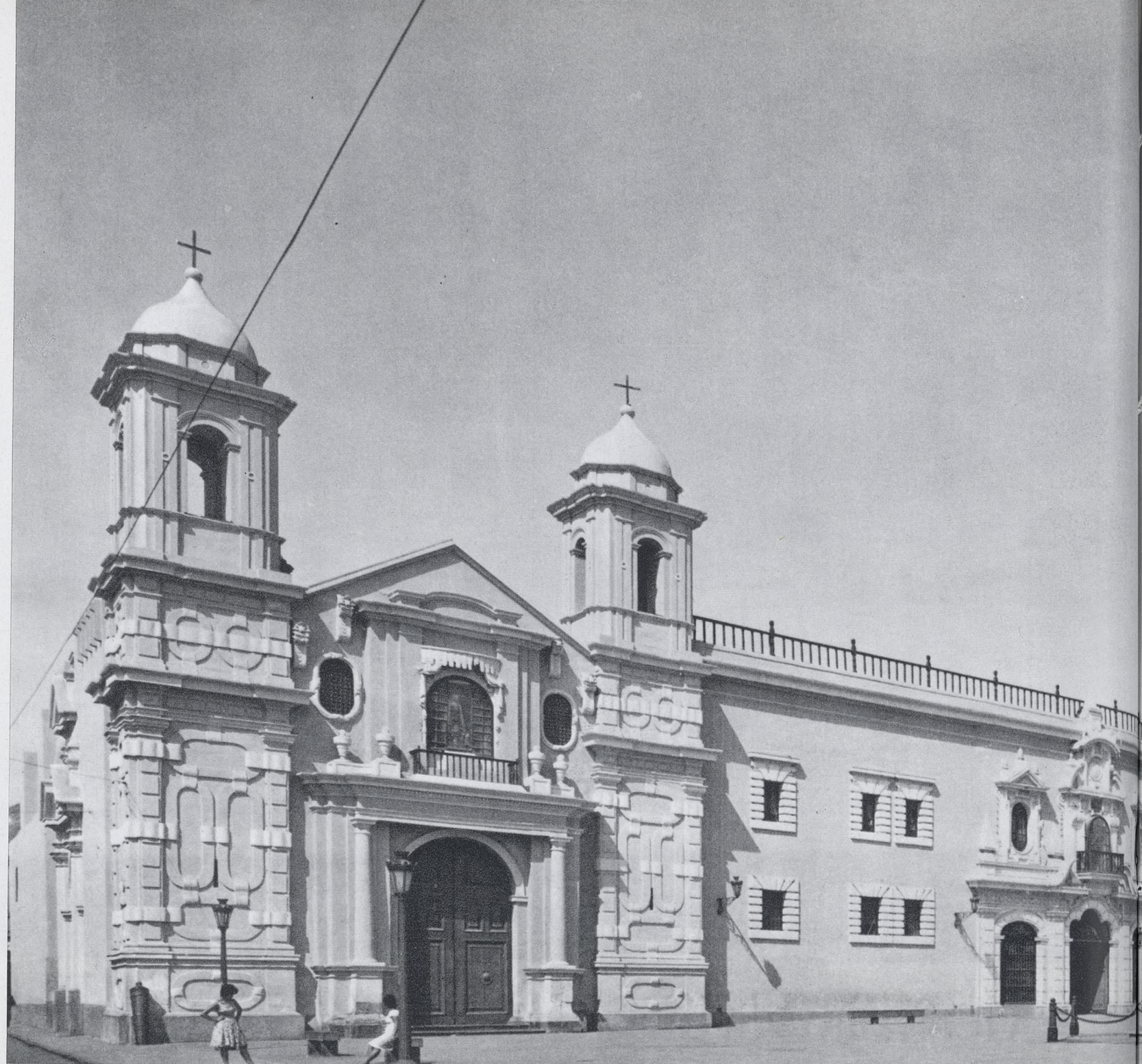
San Francisco, convento e iglesia de Lima, restaurados exteriormente y en proceso de restauración interior.
