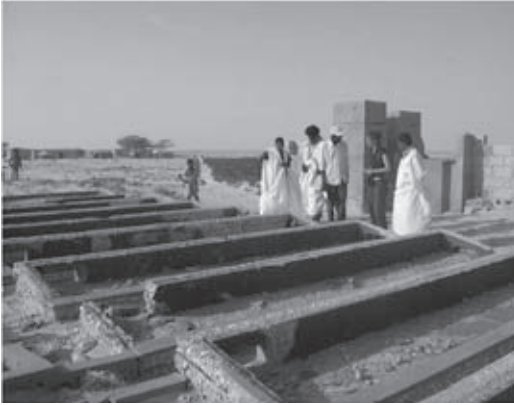
IMAGEN 1. BALAWACK. EJEMPLO DE DESTILADOR SOLAR ABANDONADO (MAURITANIA).
