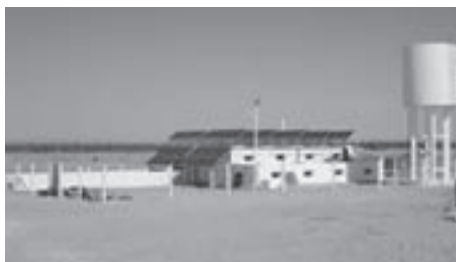
IMAGEN 3. PLANTA DE DESALACIÓN FOTOVOLTAICA DE KSAR GHILÈNE. FUENTE: ITC.
