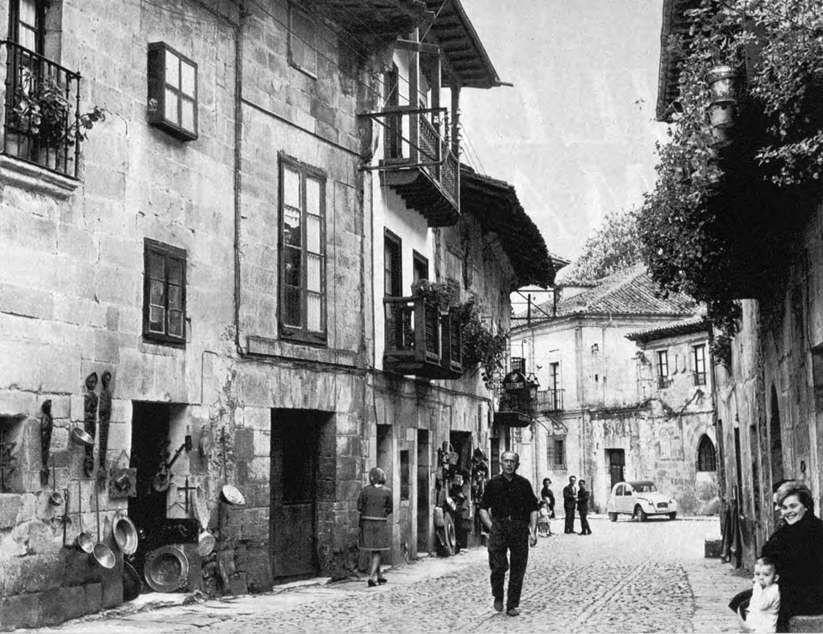
Calle de la Carrera.
