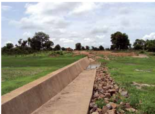
Photo 31. Bas-Fond de béton du PDRIK. Kita.
