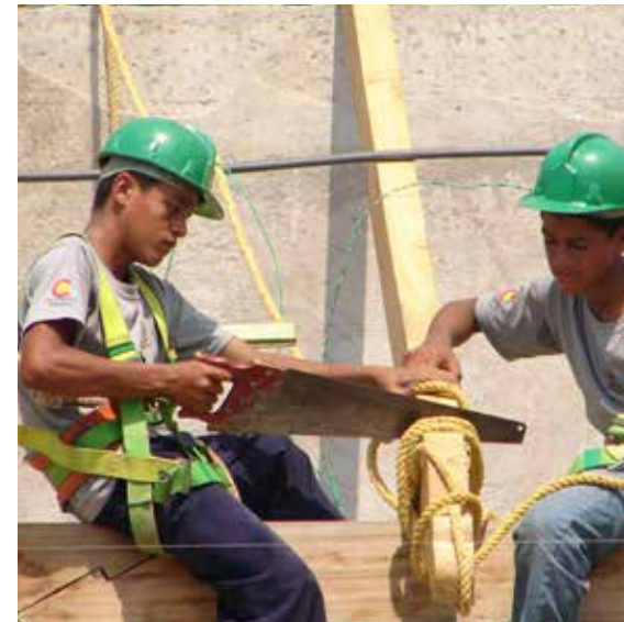
▲ Puerta de los Encuentros. Carpentry workshop ◄ Metalwork shop
