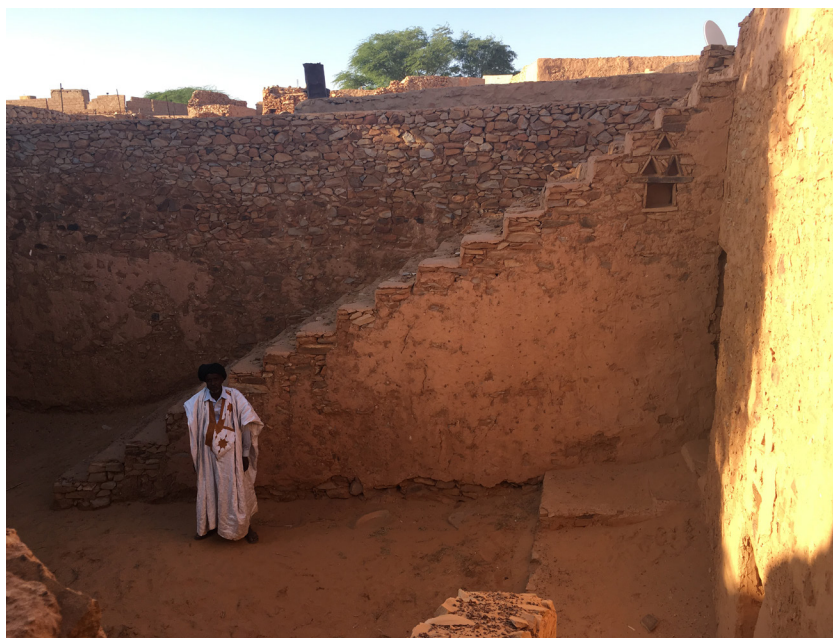
Patio de acceso a la Biblioteca Wanane
