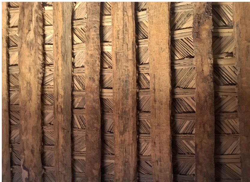
Forjado tradicional en una vivienda de Chinguetti
