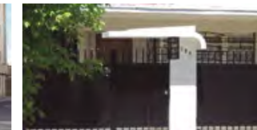
T Voladizo acceso vivienda
