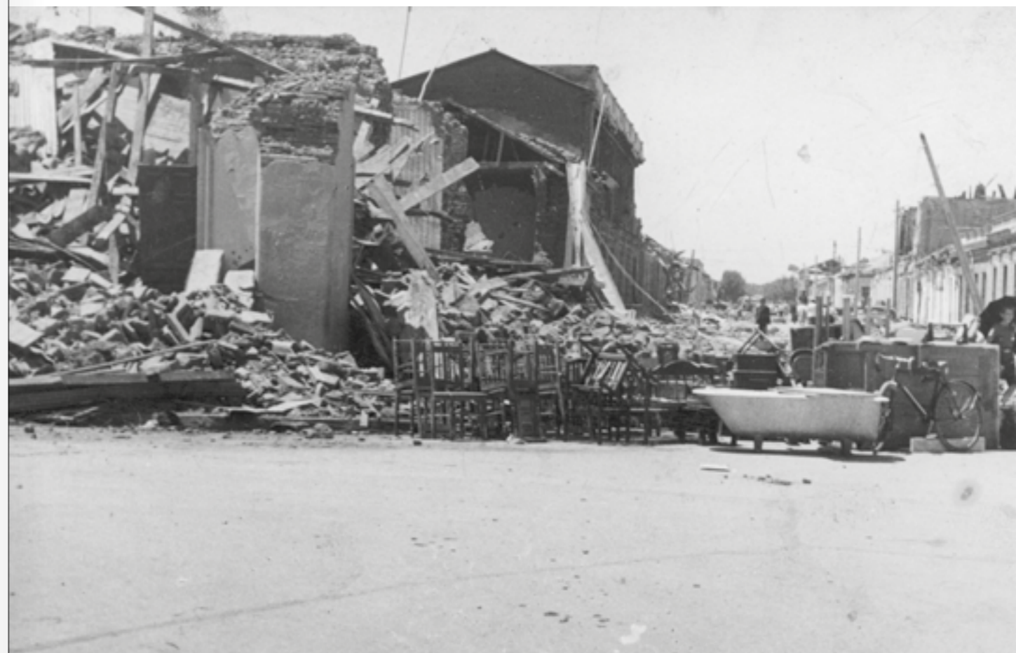
Escombros en localización no identificada. Fuente: Archivo Unidad de Patrimonio de la Municipalidad de Chillán.
