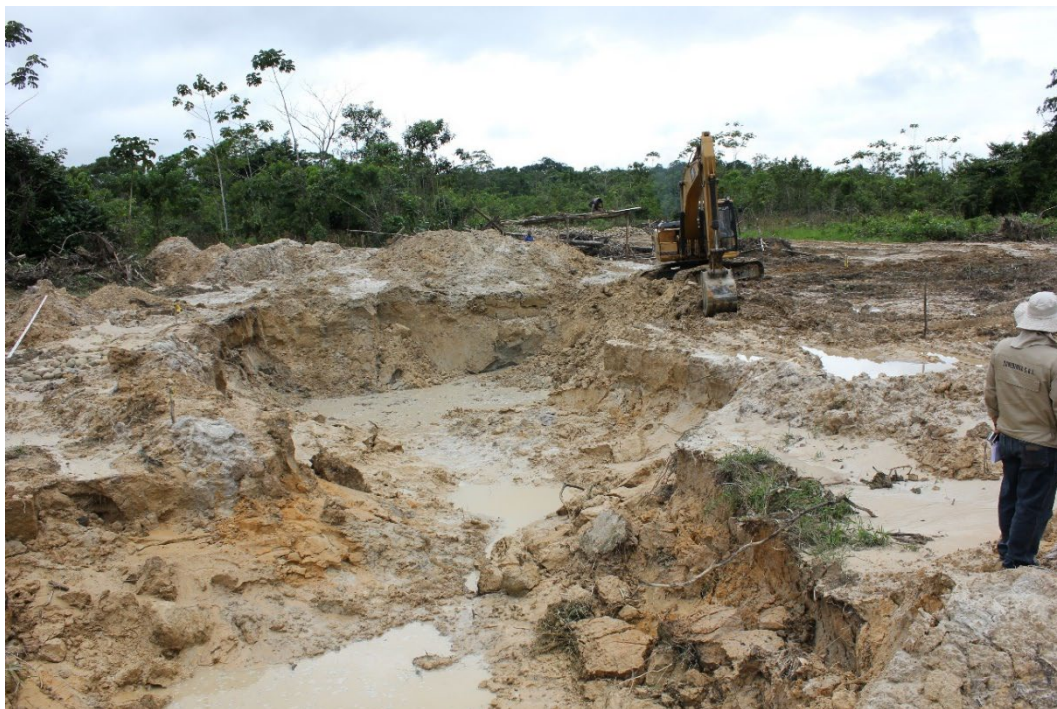
Figura 20 Obras de construcción de la PTAR de Mariposas (Bolivia).
