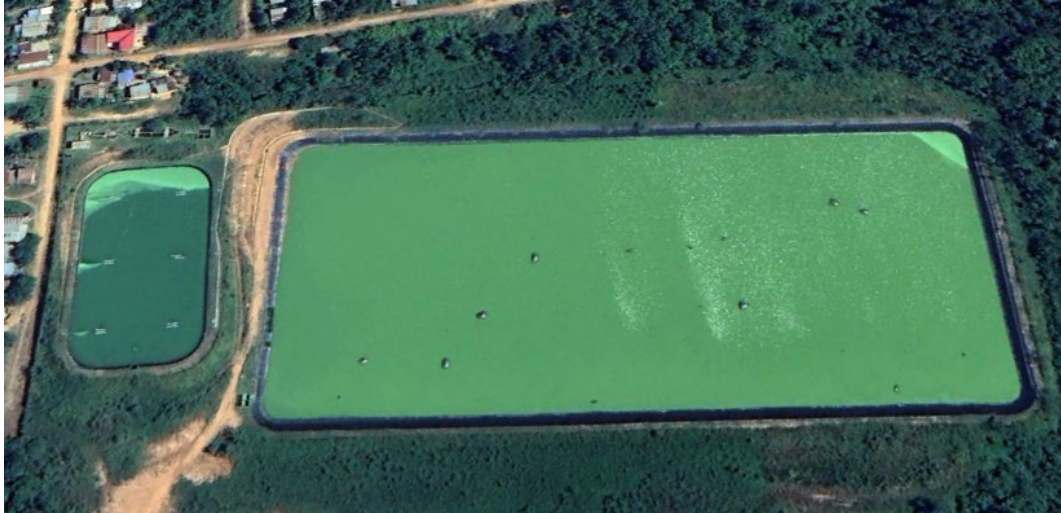
Figura 22. Levantamiento de la geomembrana por embolsamiento de gas en la PTAR de Cobija, Bolivia. Fuente: Google Earth
