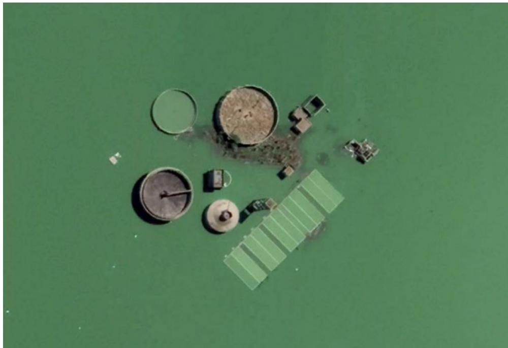
Figura 25. Planta de tratamiento de Pehuajó, Argentina
