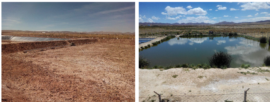
Figura 9. Área de infiltración de la PTAR de Konani (Bolivia). En construcción (izquierda) y saturada tras varios años de funcionamiento (derecha)
