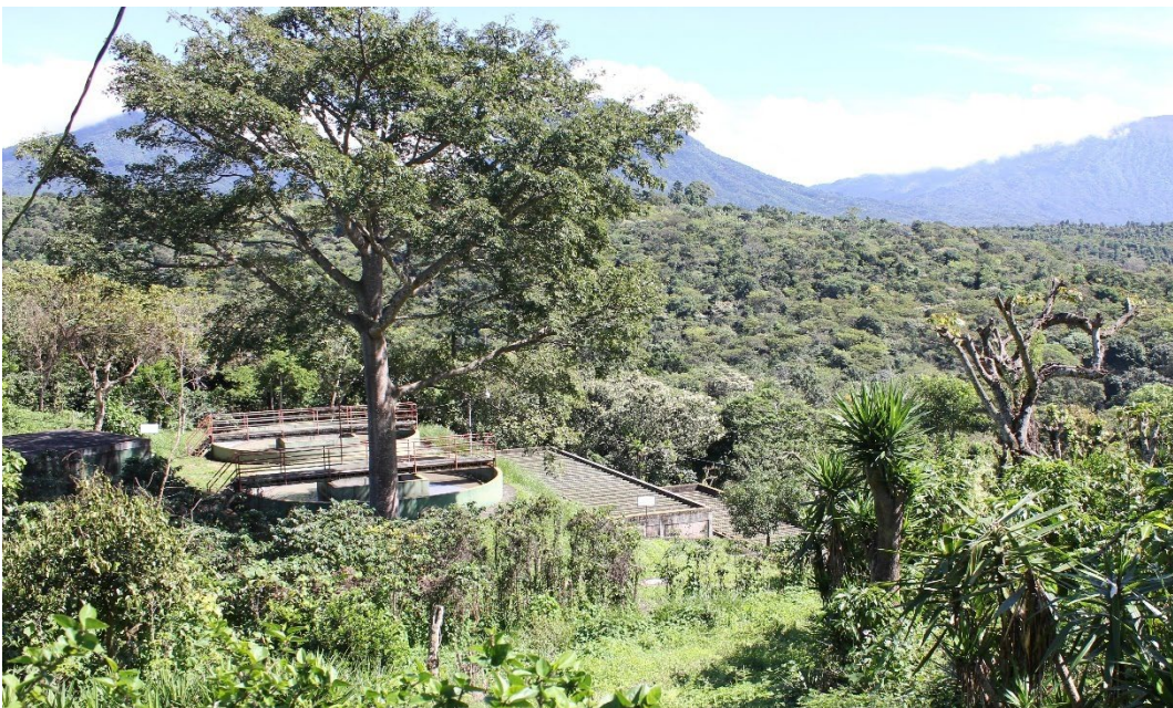
Figura 13 PTAR con doble etapa de filtros percoladores en El Salvador.
