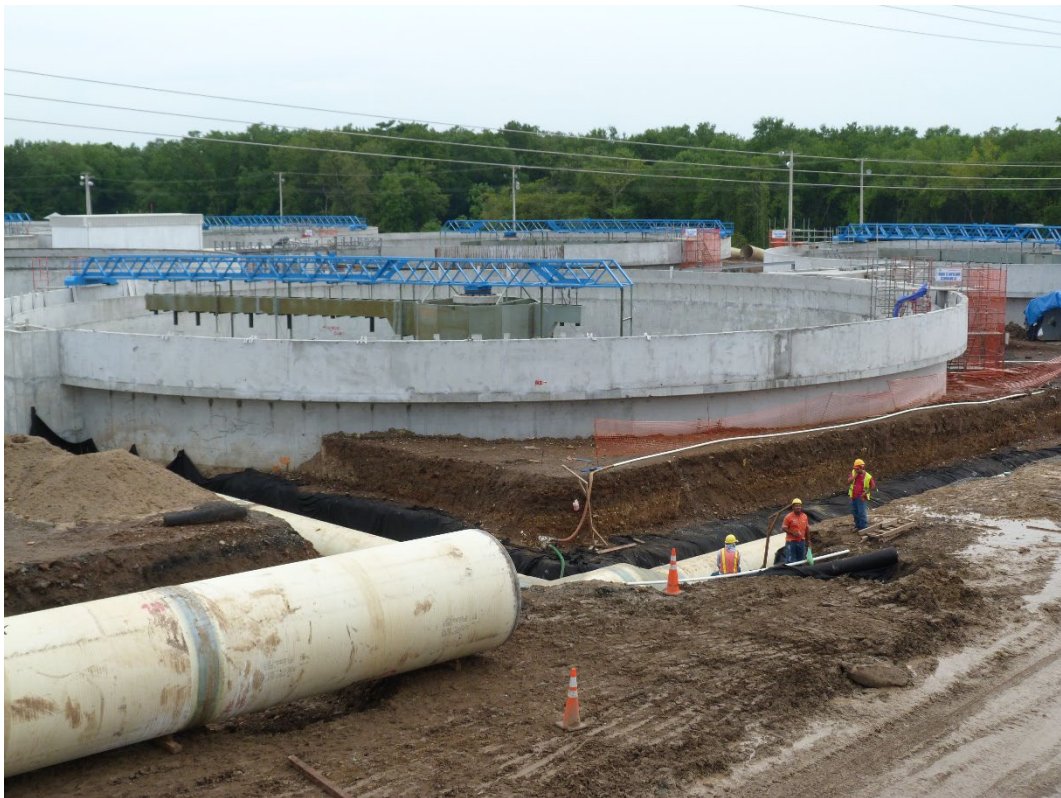
Figura 14 Obras de construcción de la PTAR de Juan Díaz, Panamá.
