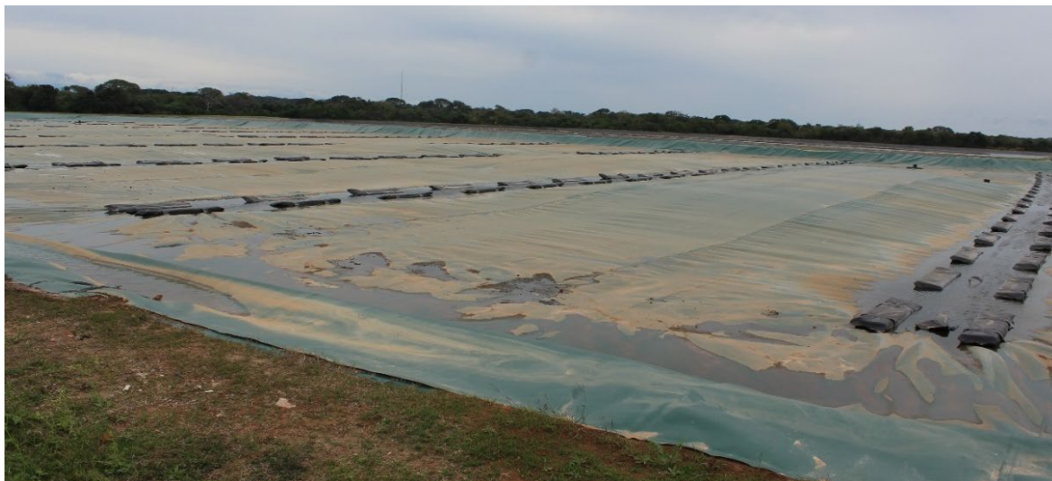
Figura 5 Lagunas anaerobias cubiertas (Santa Cruz, Bolivia)
