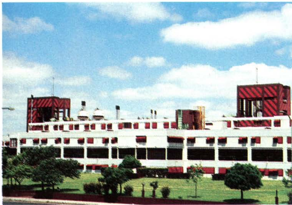
Hospital Nacional de Pediatría, Estudio Aftalión, Bischof, Do Porto, Escudero, Egozcue, Vidal, 1973/78. Aplicación de arquitectura de sistemas
