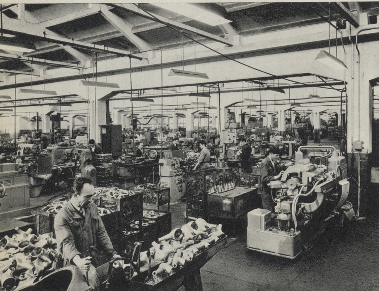
Vista parcial de la sección de máquinas.
