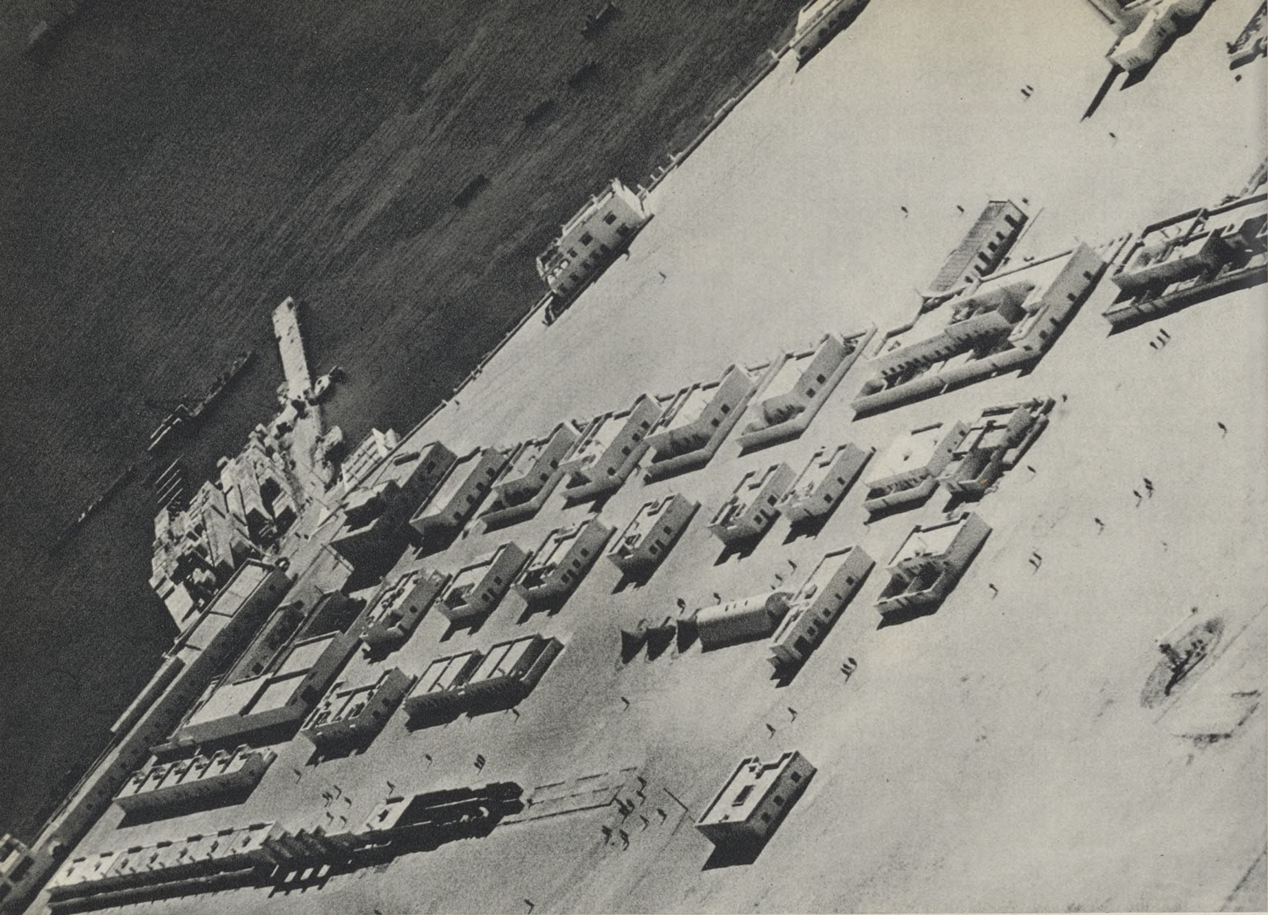
Vista general de Villa Cisneros, con el nuevo puente en construcción.
