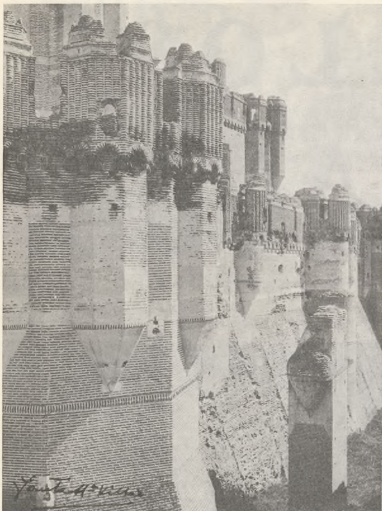
Castillo de Coca. Vista de uno de los lienzos, con sus grandes garitones, su escarpa y su foso. Construido de ladrillo, Lampérez lo conceptuó como arquetipo del estilo mudéjar.
