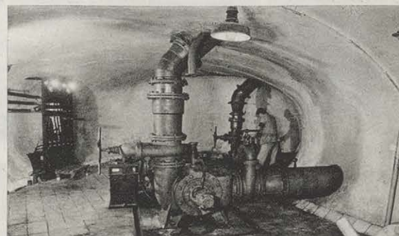
La Obra Sindical de Colonización inició su labor con el pozo de Daimiel (Ciudad Real), que, con un caudal superior a los 1.000 litros por segundo, fecunda más de 1.000 hectáreas de tierras antes áridas por falta de agua. Su sala de máquinas, instalada bajo el pozo, a 27 metros de profundidad, eleva el agua por cuatro gruesos caños.
