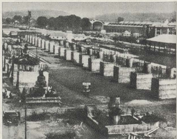
23 DE AGOSTO.—FRANCO, EN ASTURIAS. Una vista general de las obras de los talleres de laminación de la Siderúrgica Española, que ha sido visitada por el Generalísimo en Avilés. En esta población inauguró las instalaciones de la Siderúrgica Asturiana.
