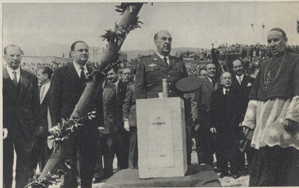
Acto de colocación de la primera piedra en los terrenos del nuevo estadio Gamper.
