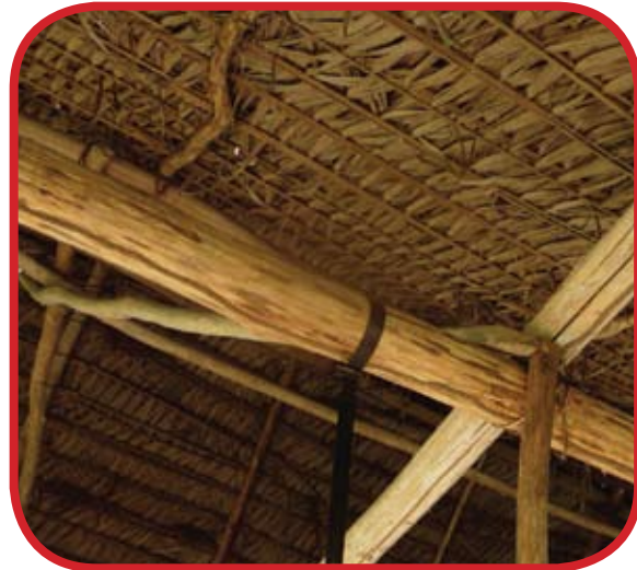
Vivienda con techado de hojas de Yarina y cercado con Cashapona
