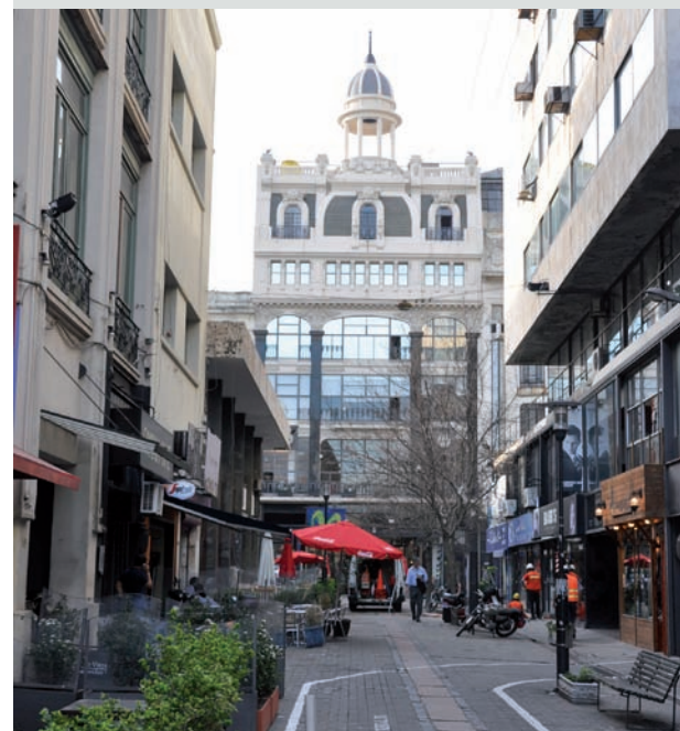
Rue Pérez Castellano Réhabilitation d'un espace public – zone piétonne de Bacacay
