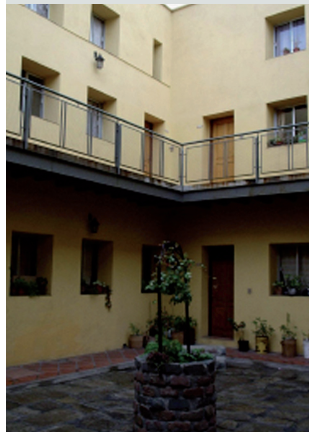
Réhabilitation et recyclage des logements
