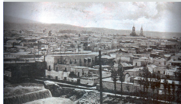
Arequipa 1865 - Vue partielle du Puente Real et des tambos
