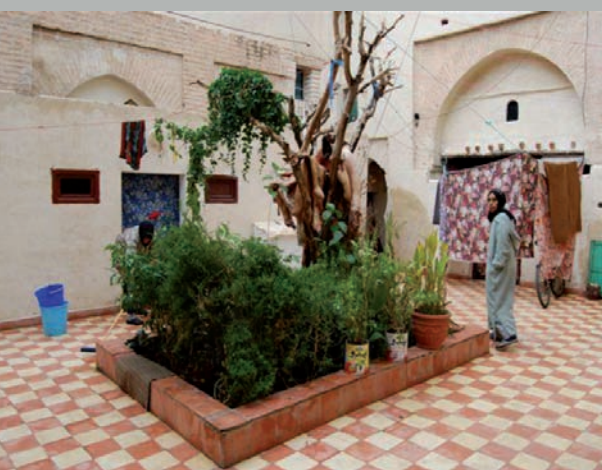
Logement délabré dans la médina Logement après intervention
