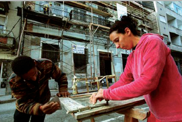
Réfection de façades – école-atelier
