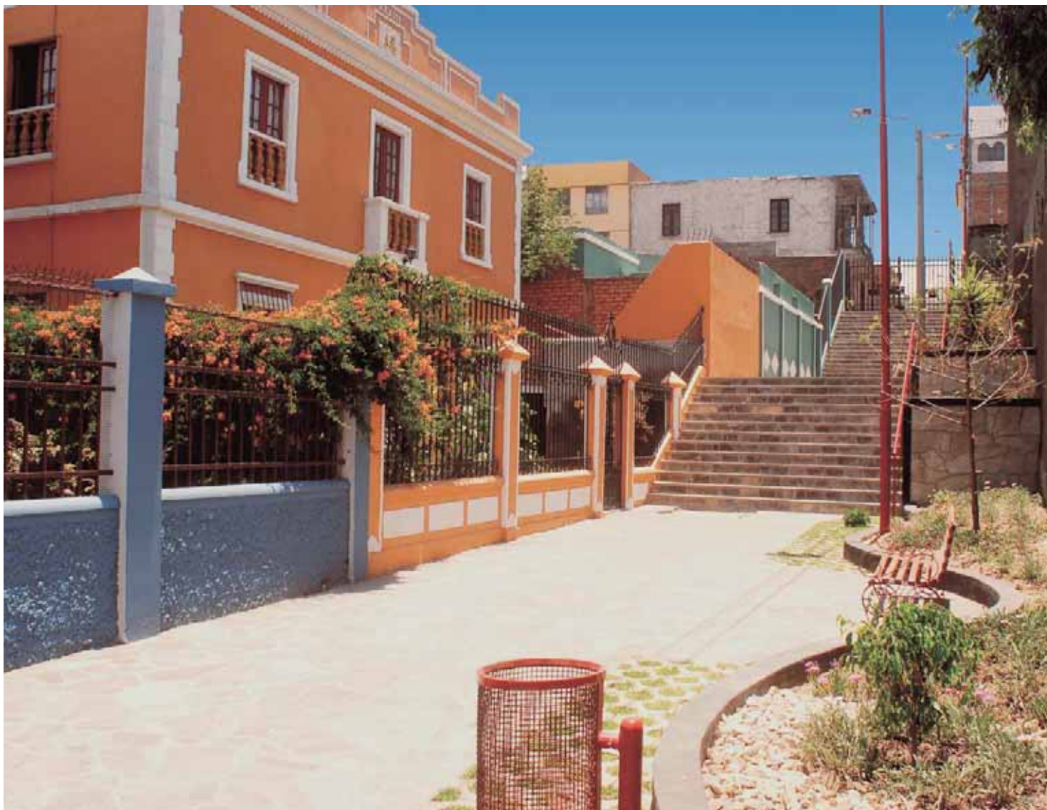
Pasaje 28 de Julio rehabilitado
