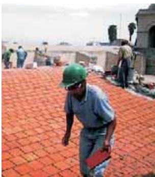
Restauración de cubiertas
