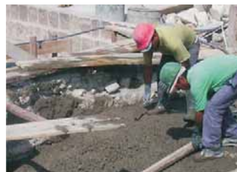
Consolidación estructural de bóveda
