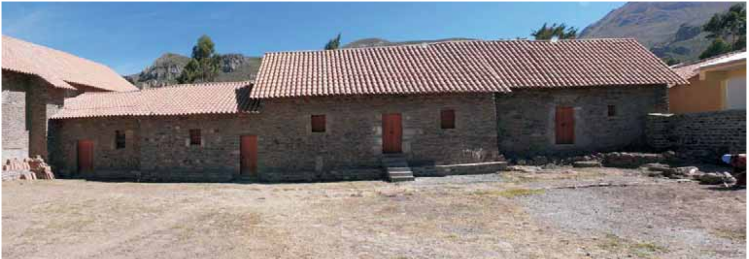
Antigua casa cural de Coporaque rehabilitada (sector norte)
