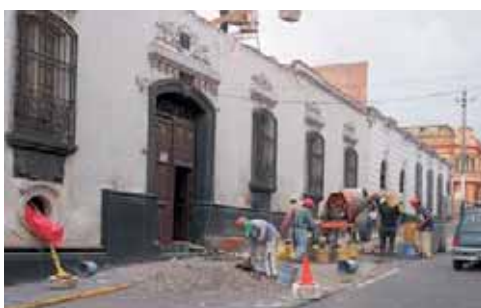
Trabajos de restauración de la Casa Meneses
