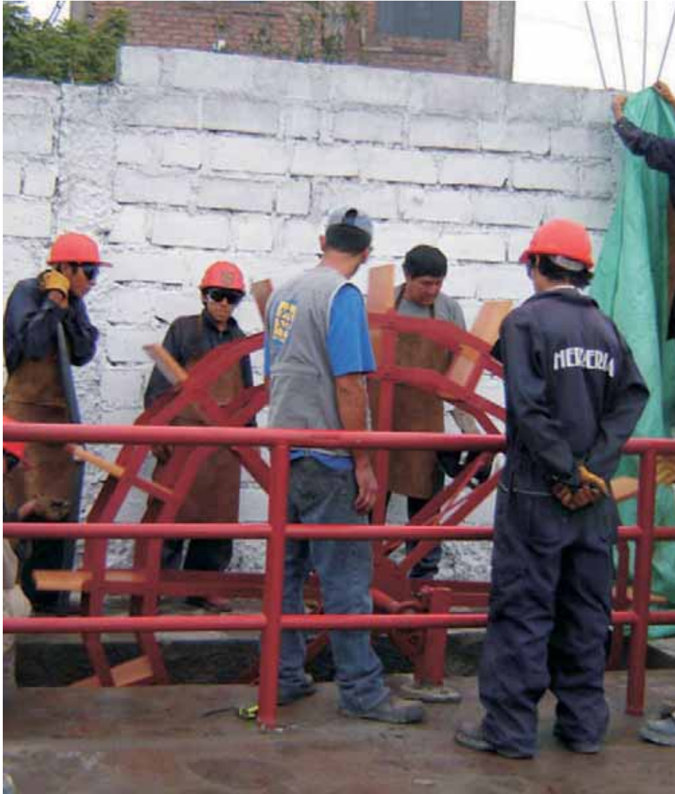
Instalación del molino
