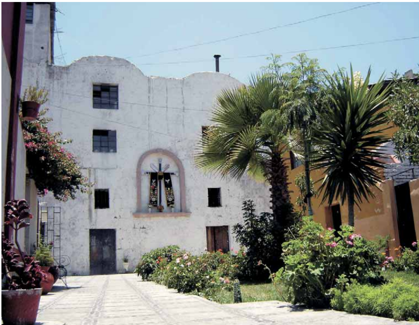
Patio principal después de la intervención
