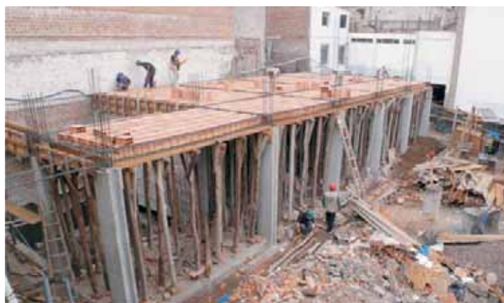
Proceso de construcción
