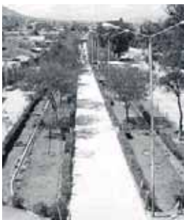
Alameda antes de la intervención
