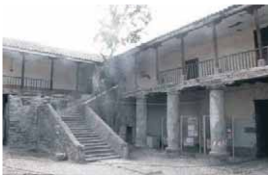
Sector sur antes de la intervención
