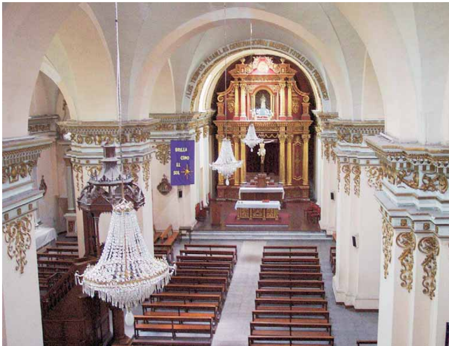
Interior restaurado del templo de San Antonio Abad
