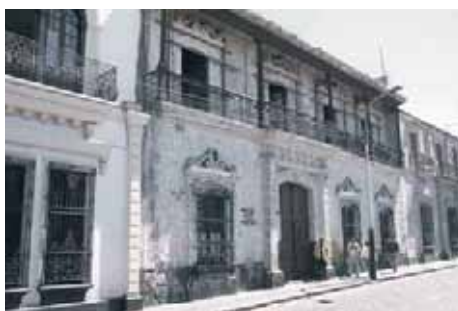
Casa del corregidor Maldonado antes de la intervención
