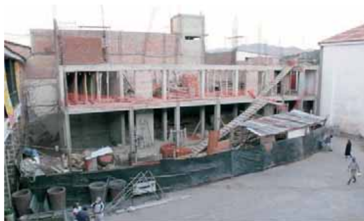
Proceso de construcción
