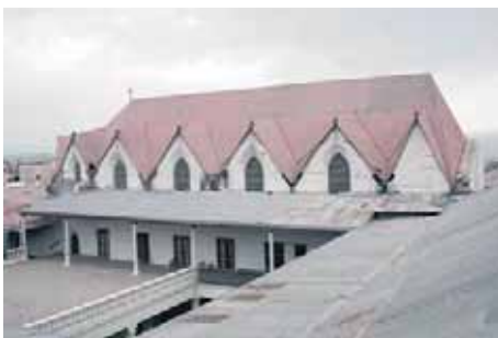
Capilla de los Sagrados Corazones antes de la intervención
