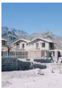
Proceso de construcción
