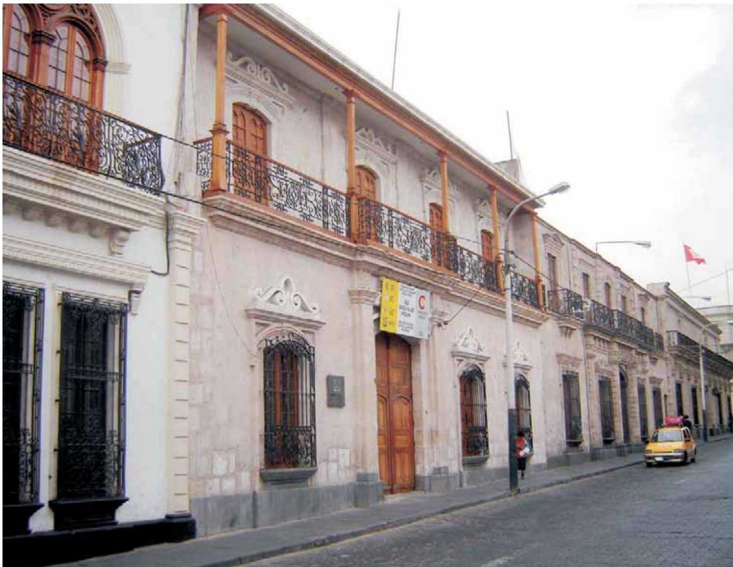
Casa del corregidor Maldonado restaurada
