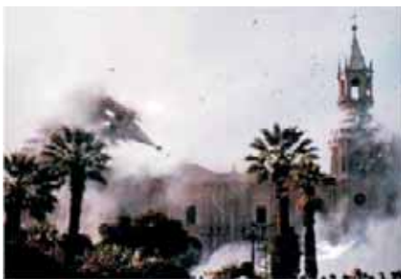
Caída de torres durante el terremoto del 2001
