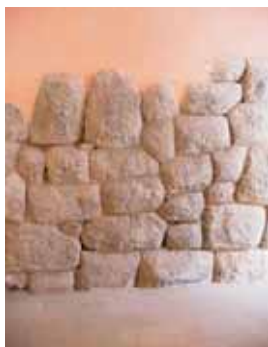
Muro con aparejo inca
