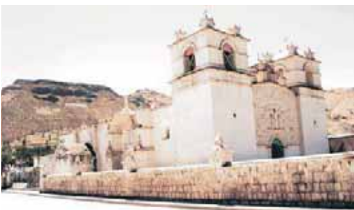
Templo antes de la intervención
