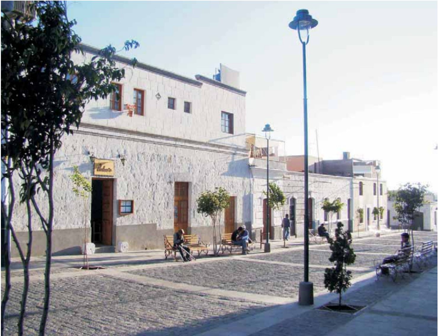
Calle Campo Redondo rehabilitada
