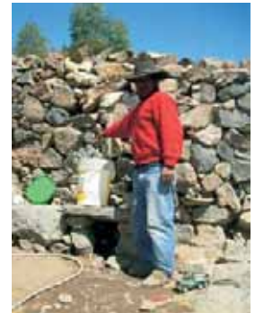
Pileta antes de la intervención
