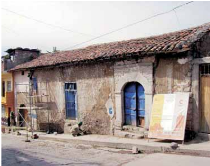
Fachada en proceso de intervención
