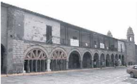
Apuntalamientos de emergencia
