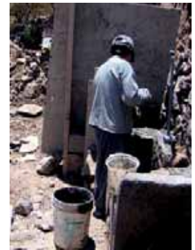
Trabajos de construcción
