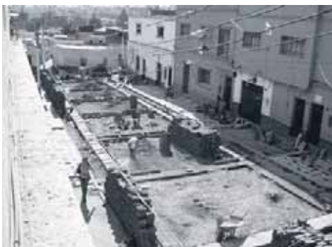
Trabajos de mejoramiento de calle
