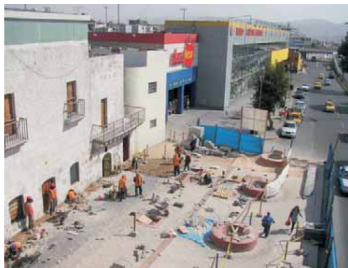
Trabajos de colocación de adoquines
