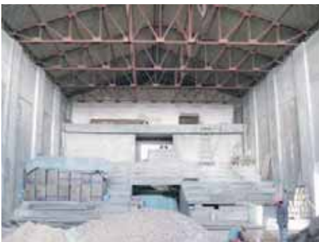
Proceso de construcción de nueva gradería
