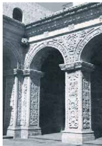
Detalle de columnas, decoración planiforme
