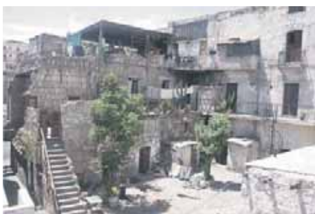
Patio antes de la intervención
