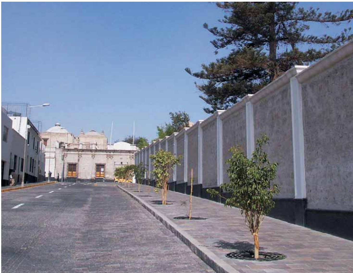
Calle Zela rehabilitada
