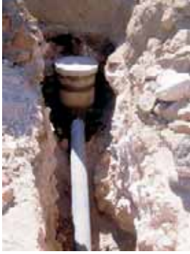
Instalación de medidor
