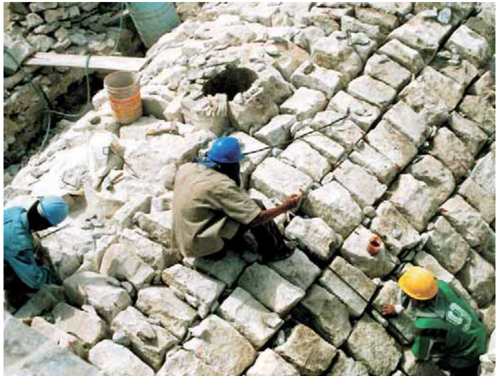
Trabajos de consolidación de bóveda
