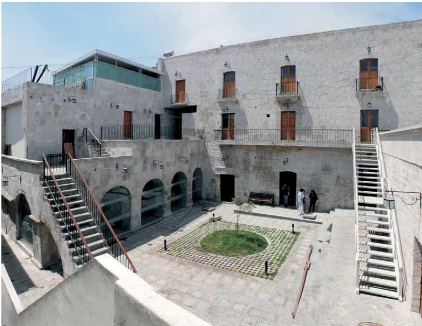
Patio del tambo de la Cabezona rehabilitado
