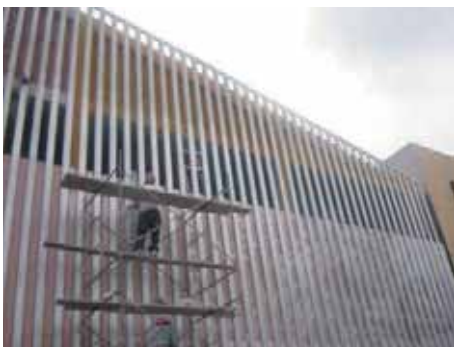
Trabajos de restauración en fachada
