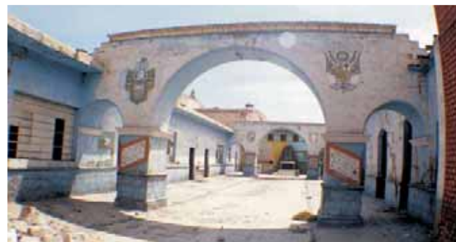
Estado previo a la intervención
