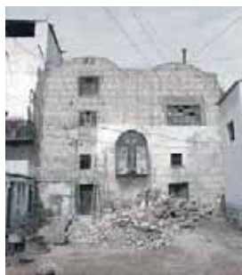
Patio antes de la intervención
