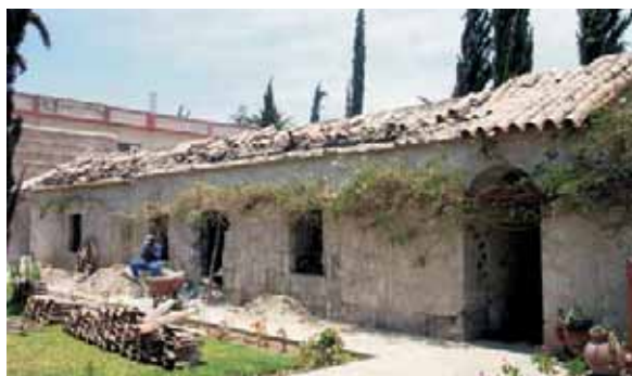
Desmontaje de tejas en cobertura
