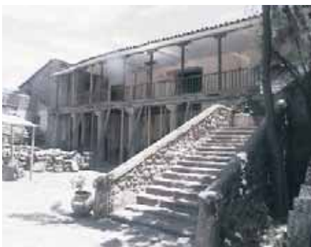
Sector este antes de la intervención
