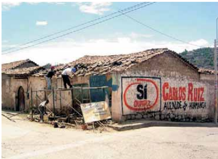
Proceso de desmontaje y reparación de cobertura
