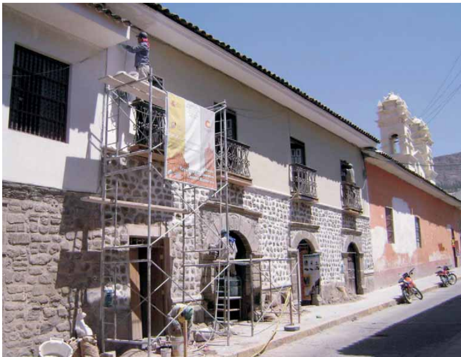
Trabajos de adecuación arquitectónica en inmueble del área monumental
