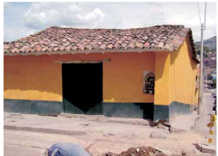
Fachada y cubierta después de la intervención
