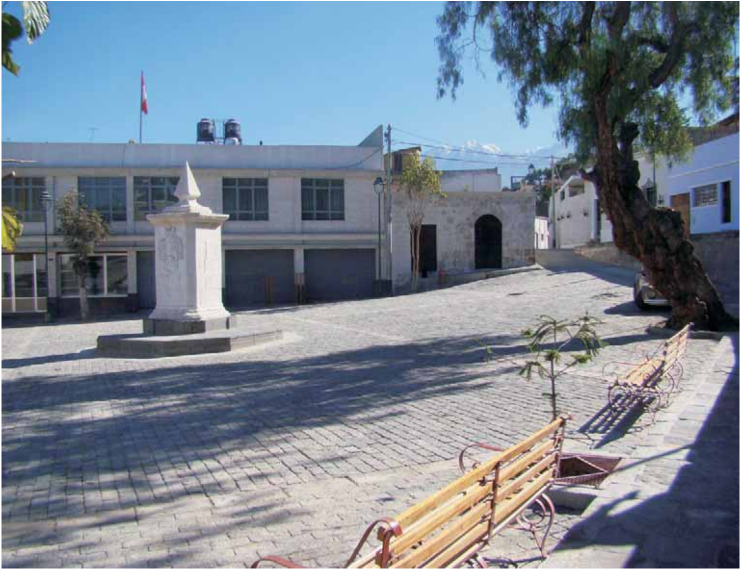
Plazoleta Campo Redondo remodelada
