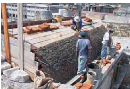
Trabajos de reconstrucción de bóveda
