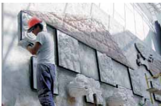
Colocación de piezas talladas en sillar
