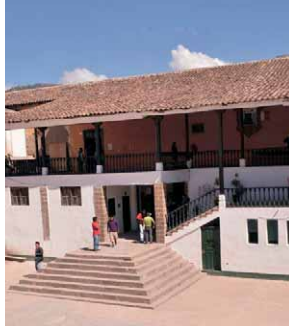
Escalera interior del patio
