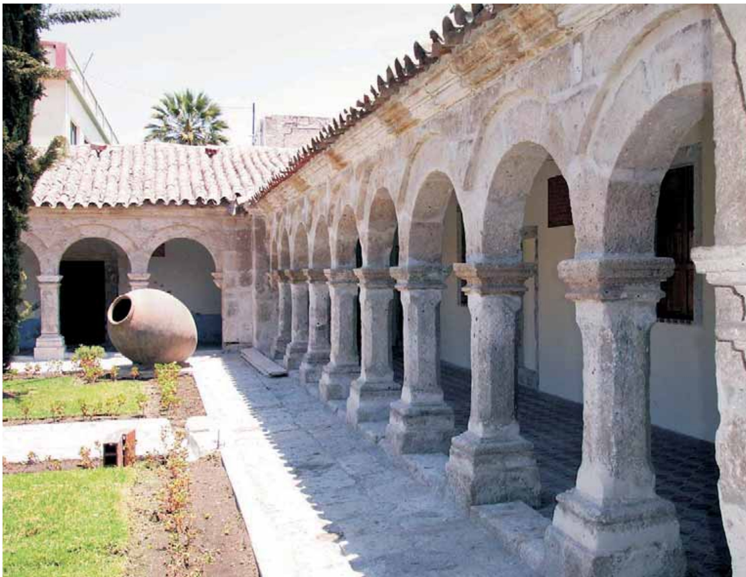
Claustro Alcantarino después de la intervención
