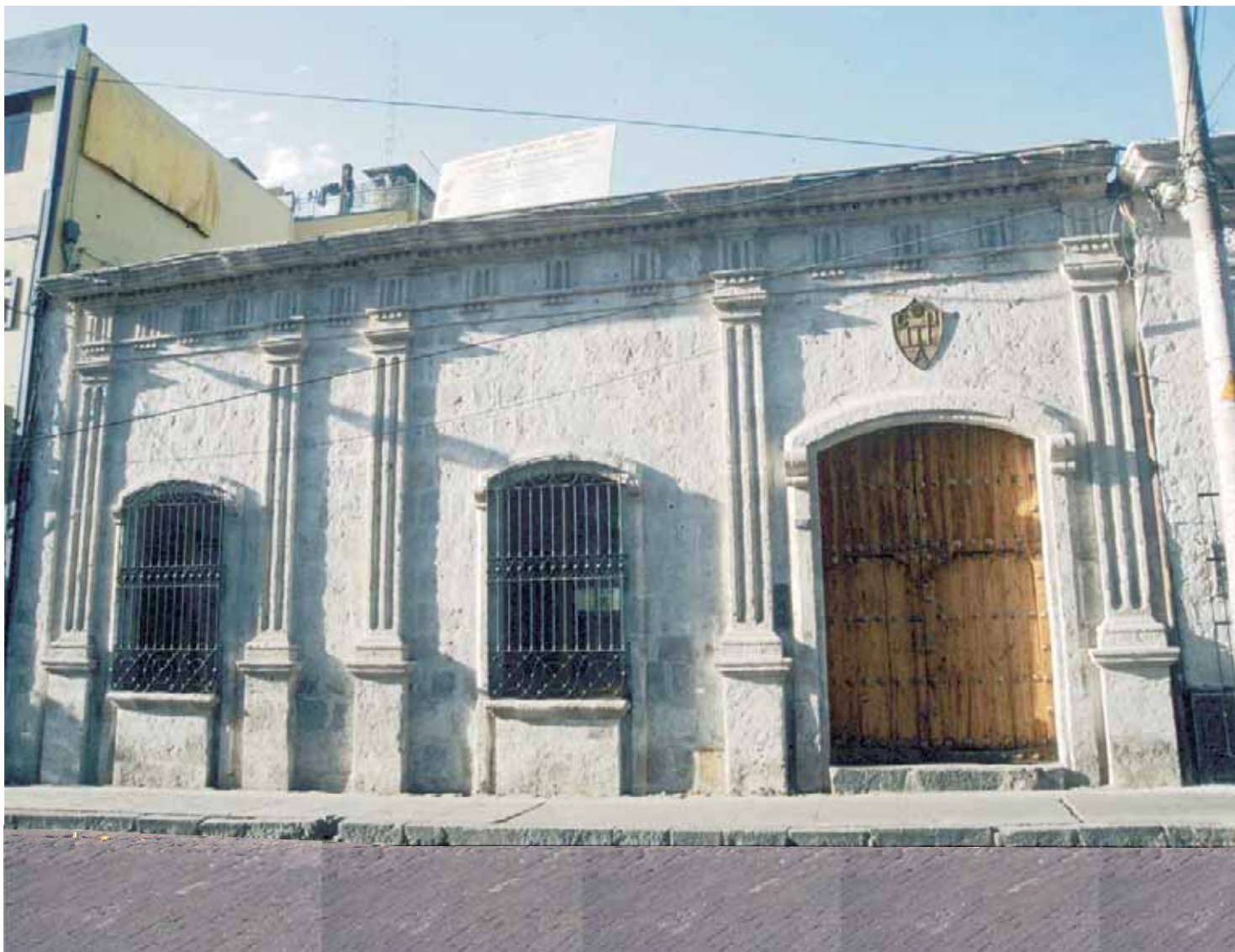
Estado actual de la fachada de la Casona Cornejo
