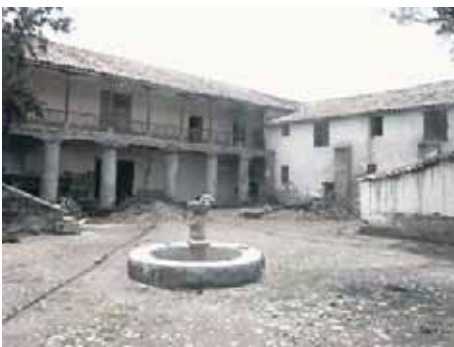
Patio antes de la intervención
