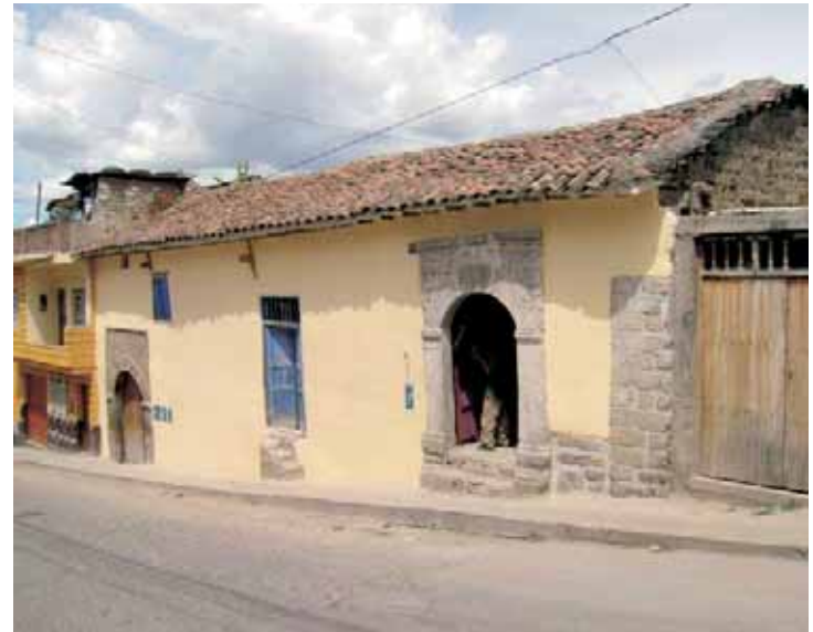
Fachada después de la intervención
