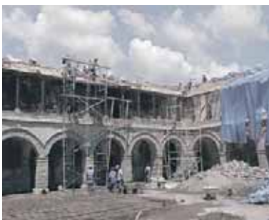
Proceso de rehabilitación
