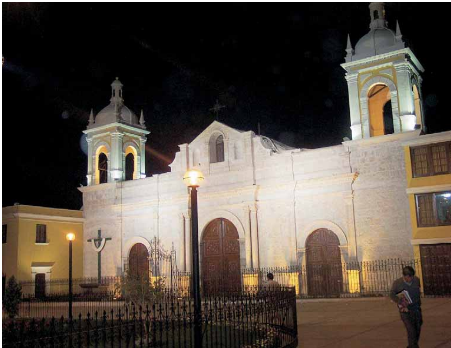
Templo de San Antonio Abad restaurado y puesto en valor
