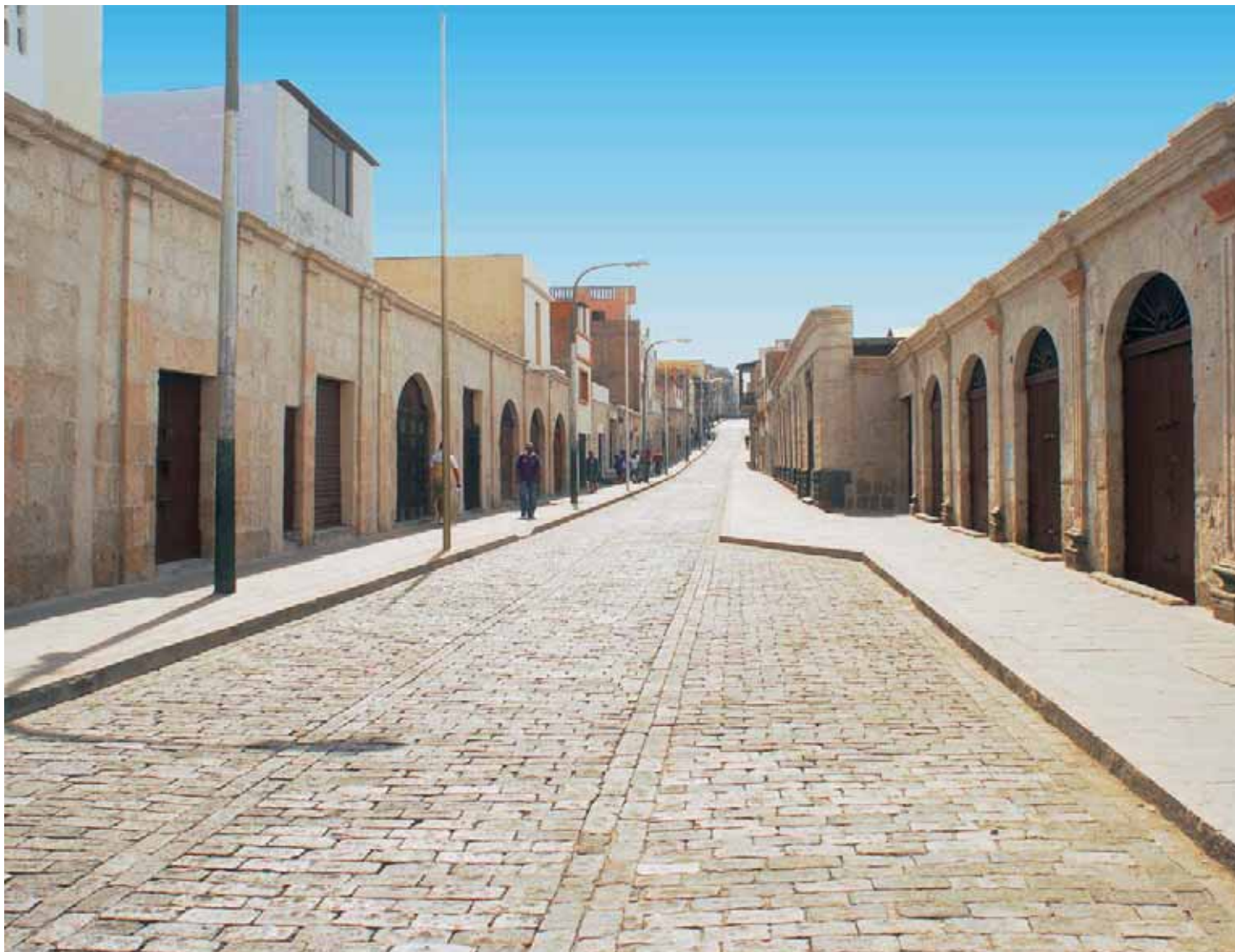
Calle Puente Bolognesi rehabilitada
