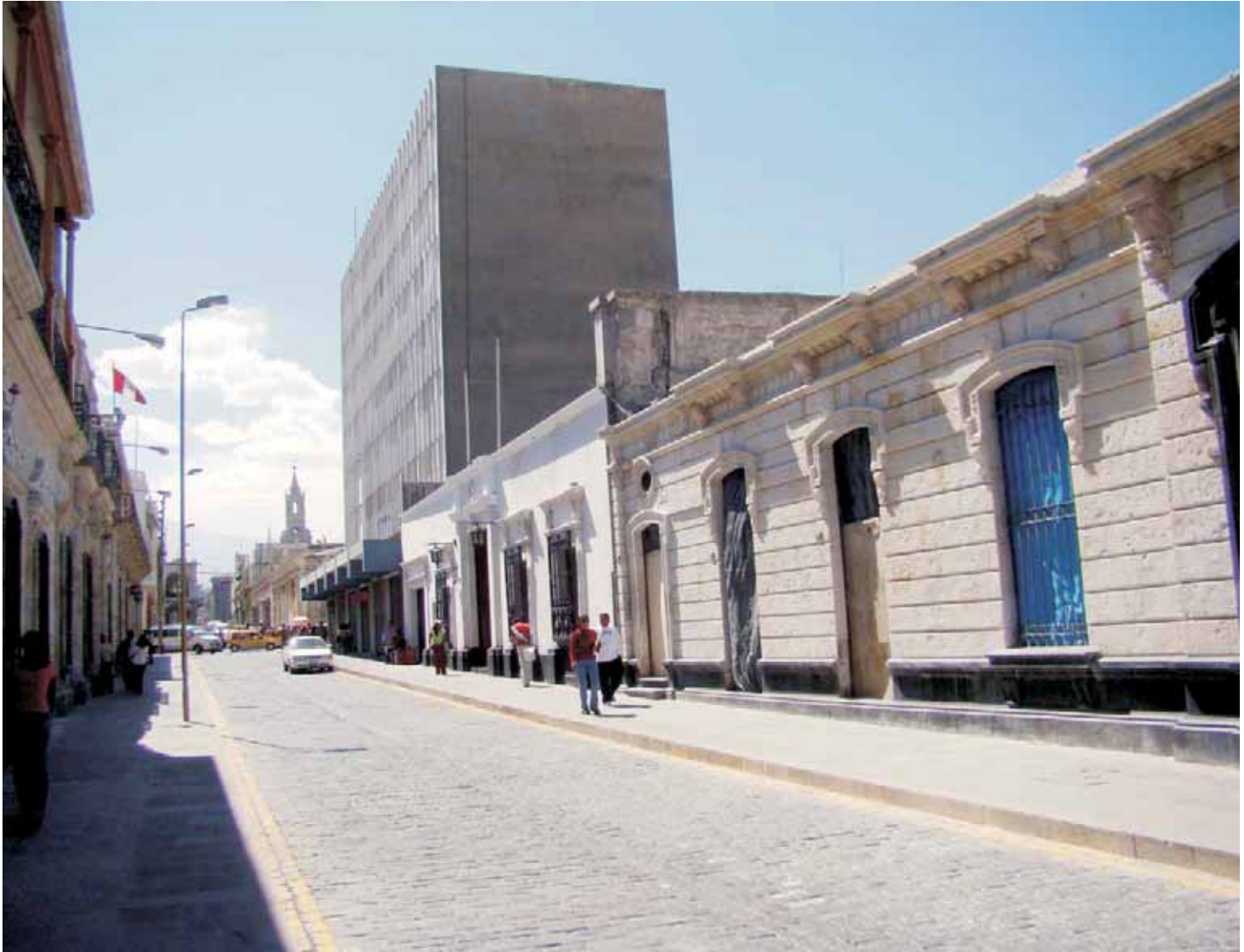
Tramo rehabilitado de la calle La Merced
