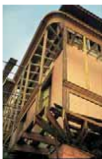
Proceso de intervención
