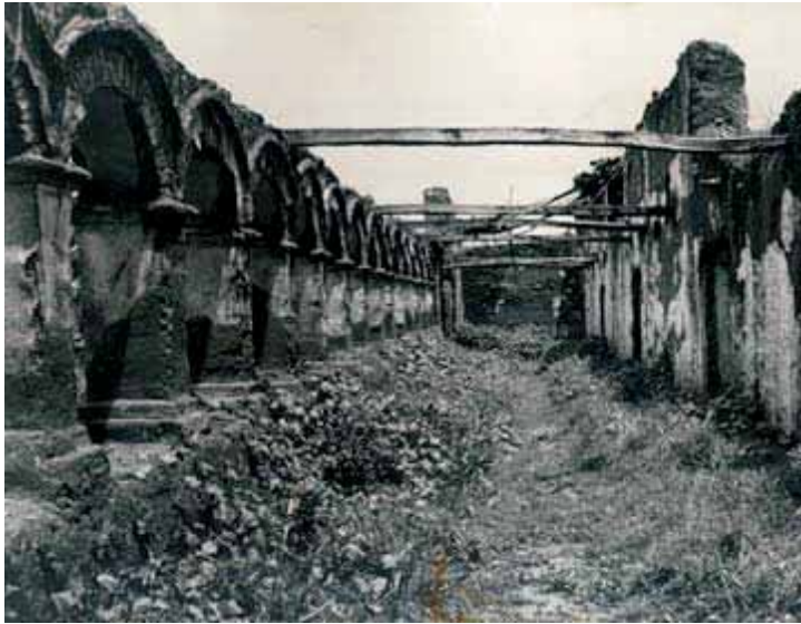
Galería antes de la restauración
