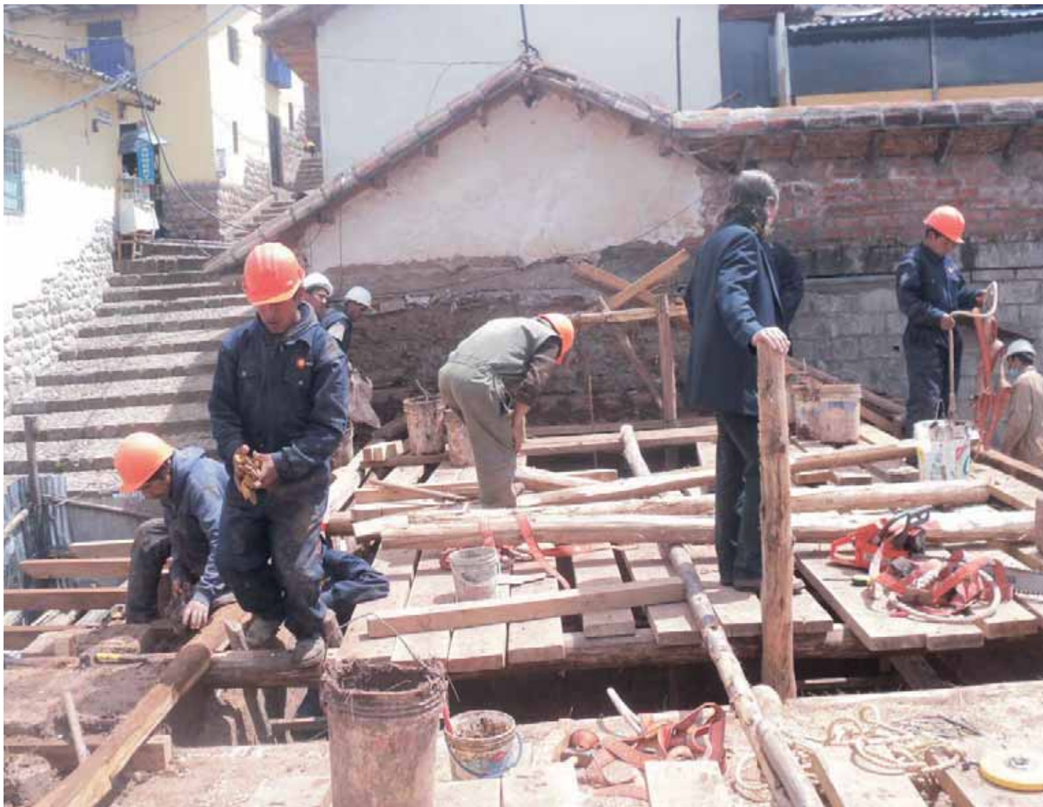
Restauración de cobertura
