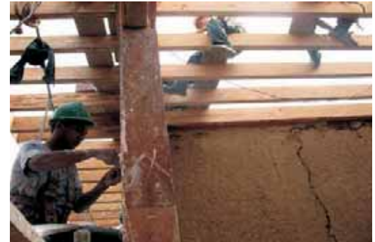
Armado de estructura de madera
