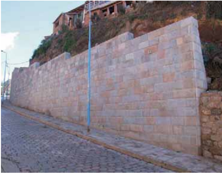
Muro de contención construido en la calle Suecia
