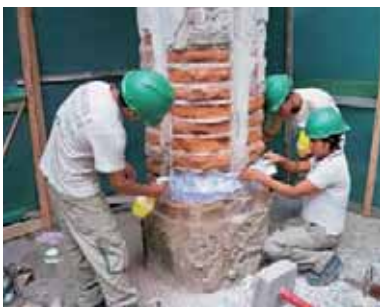
Restauración de columnas
