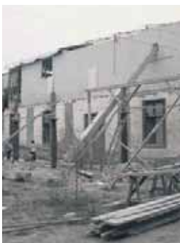
Proceso de intervención
