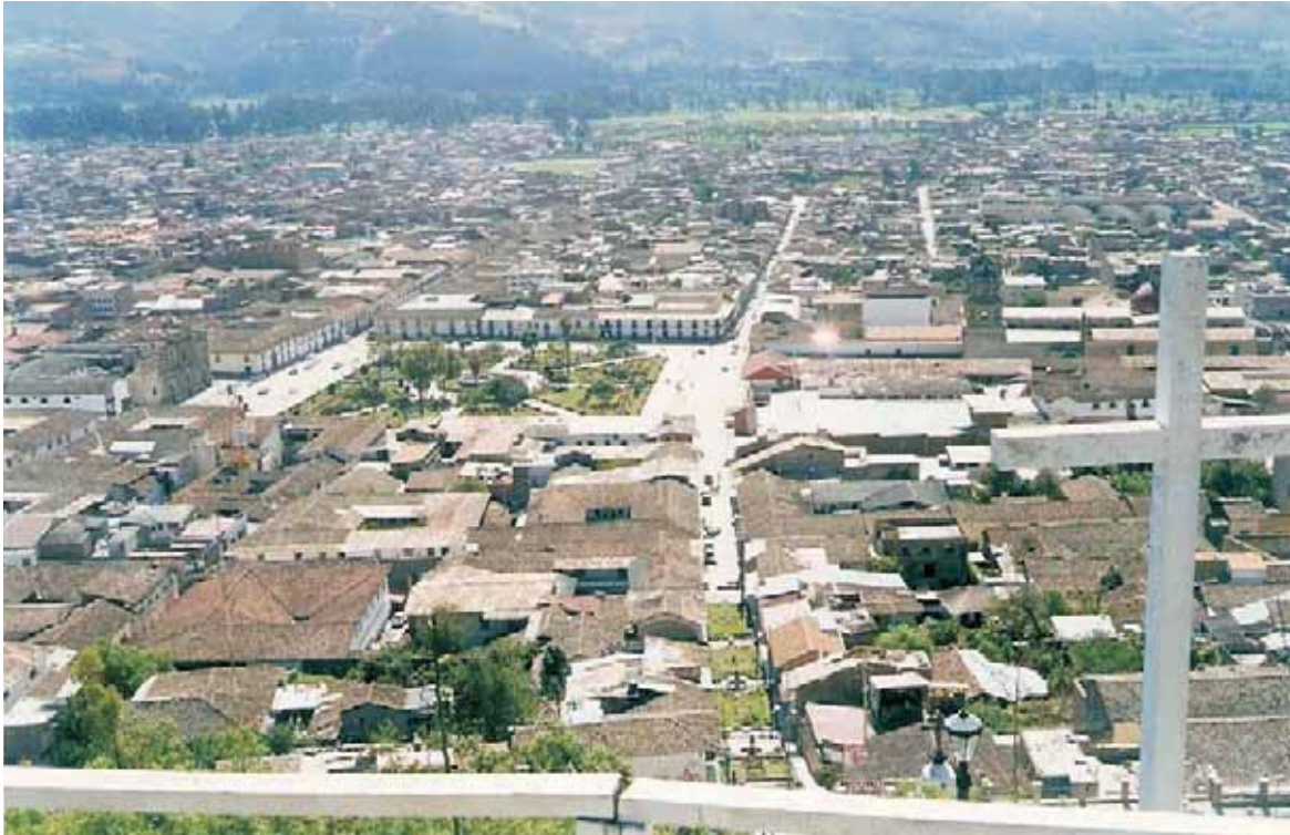
[ 1 ] Vista panorámica de la ciudad de Cajamarca
