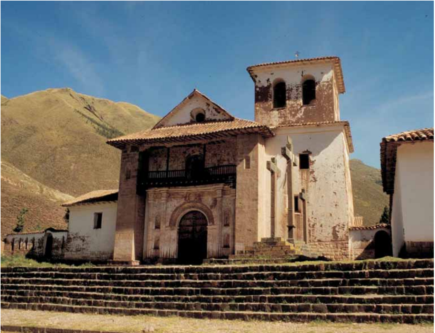
Vista exterior del templo de Andahuaylillas
