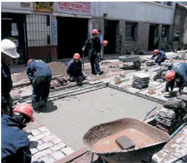
Colocación de pisos
