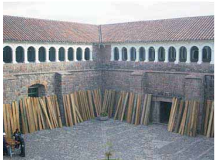
Segundo Claustro después de la restauración
