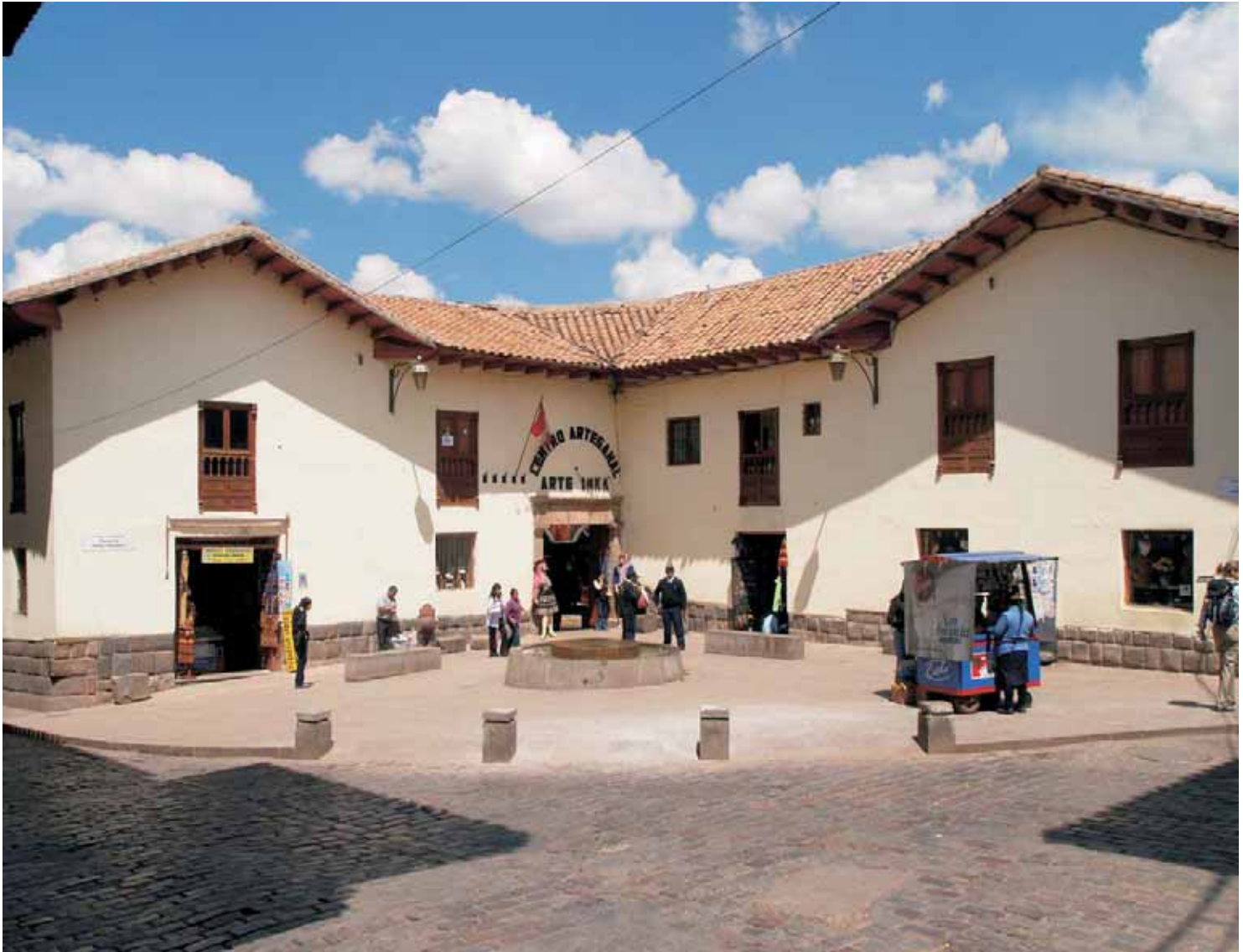
Plazoleta después de la intervención
