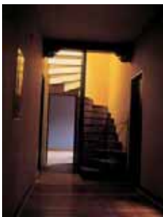
Detalle de escalera interior
