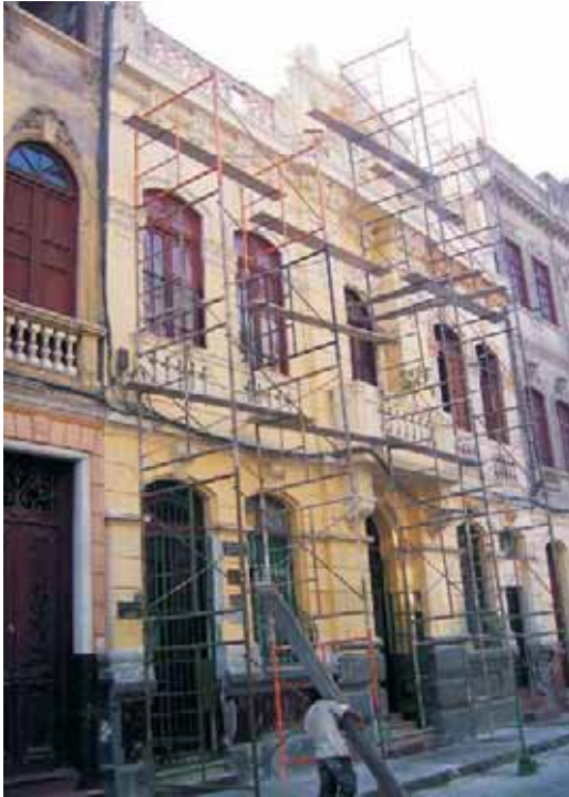
Colocación de andamios
