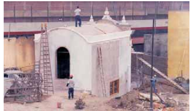
Proceso de intervención
