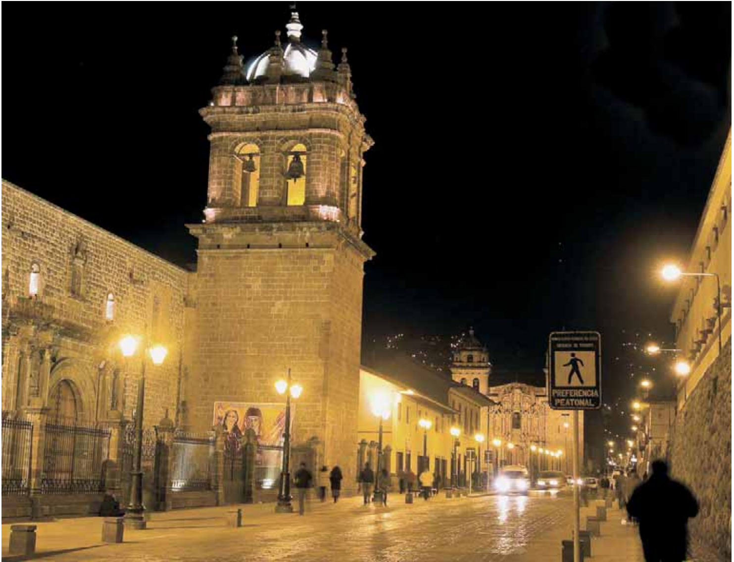
Calle Santa Clara después de la intervención
