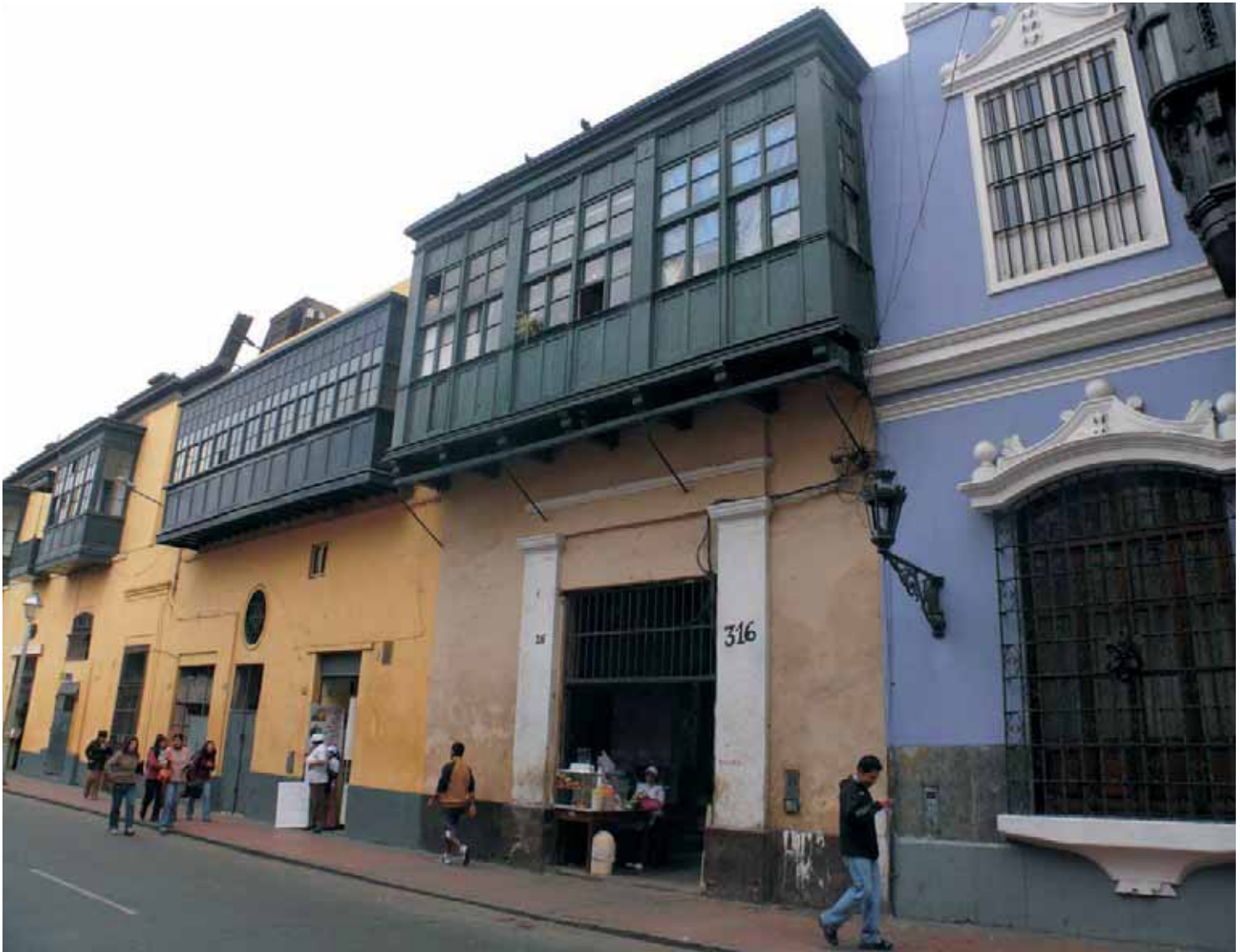
Fachada de la casa de la Columna
