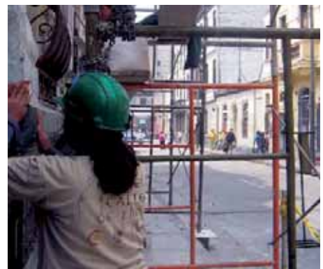
Tratamiento de muros exteriores
