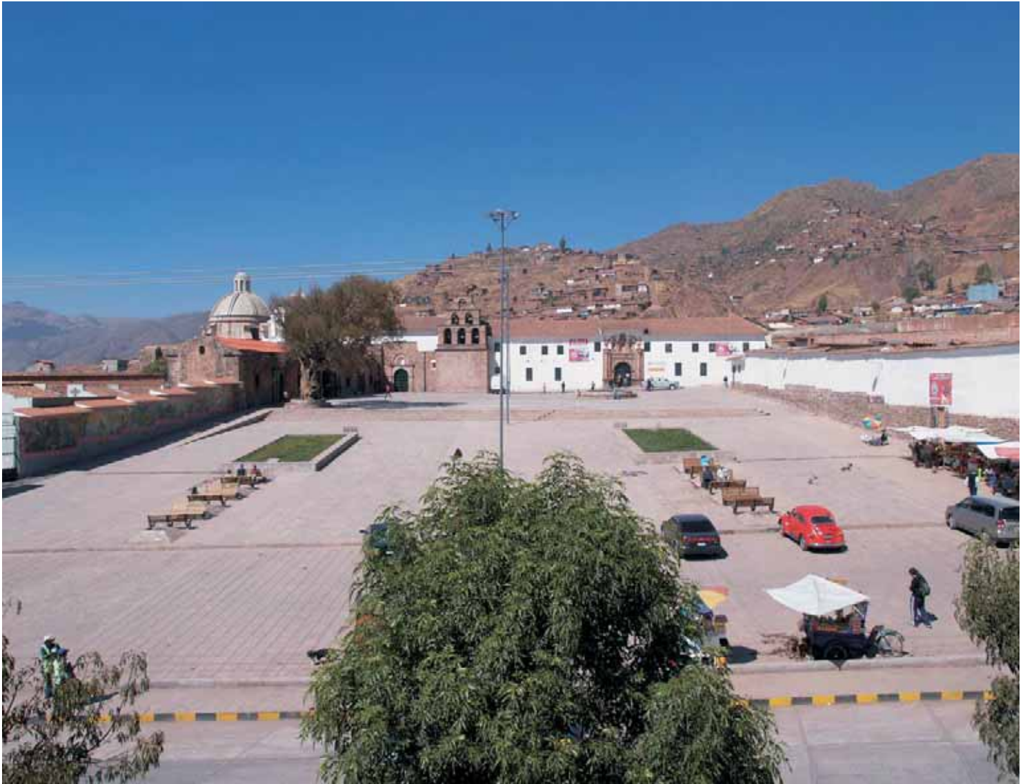
Plazoleta después de la intervención
