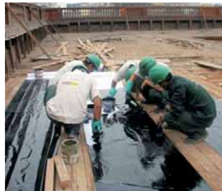
Impermeabilización de cobertura
