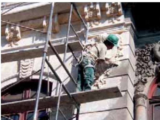
Tratamiento de fachada
