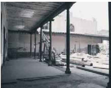
Proceso de intervención
