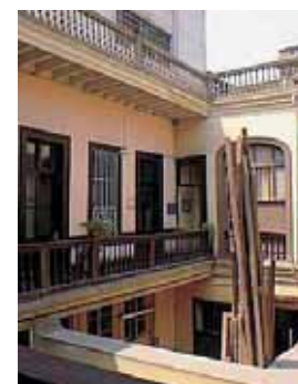
Vista del segundo nivel
