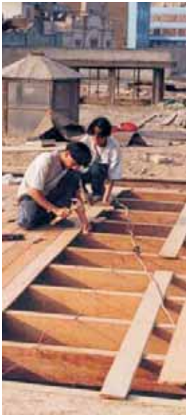
Colocación de entablado de techo
