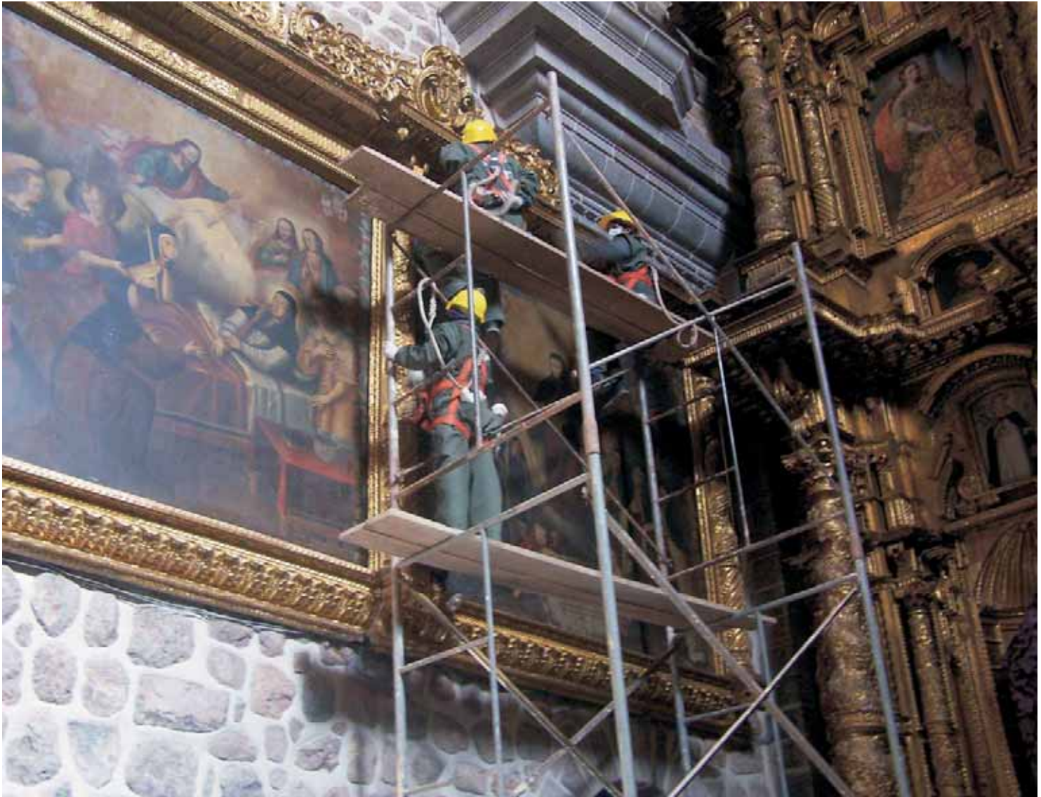
Trabajos de conservación de lienzos
