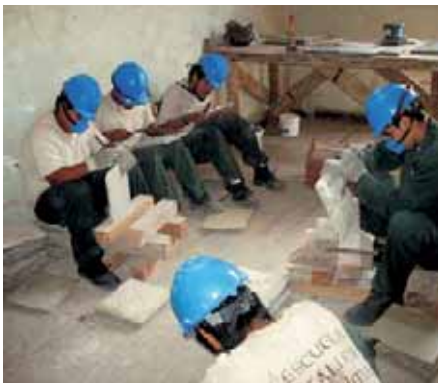
Restauración de molduras
