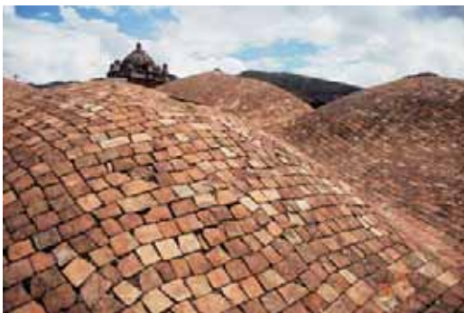
Vista de las bóvedas de cubierta
