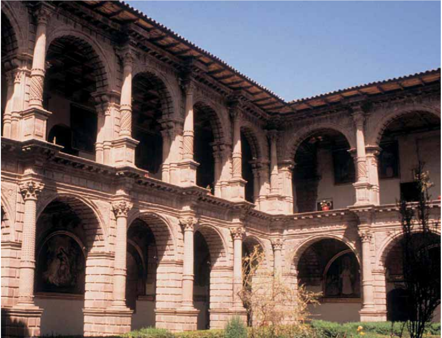
Vista del claustro principal restaurado
