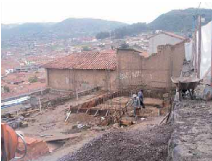
Trabajos de rehabilitación
