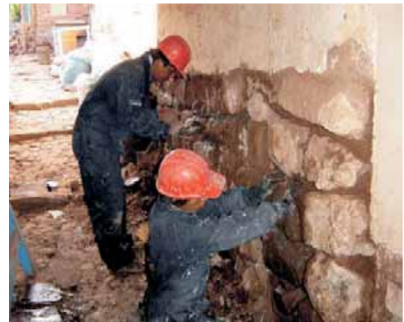
Calzadura de muros dañados
