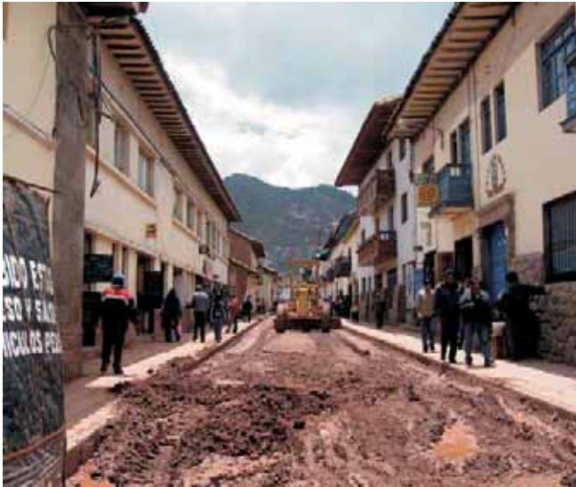
Compactado de suelo
