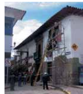
Apuntalamiento de emergencia
