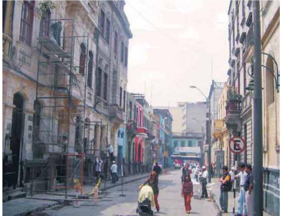
Intervención de fachadas
