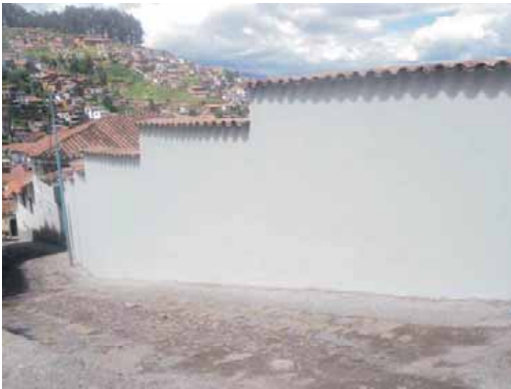
Muro rehabilitado en la calle Concepción
