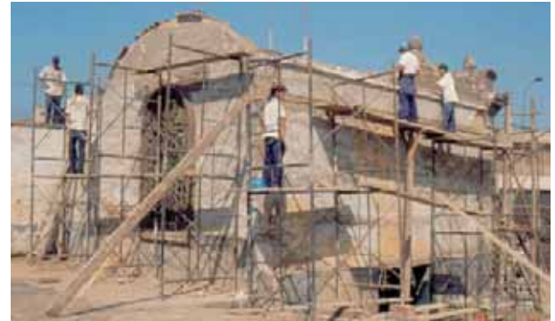
Proceso de intervención
