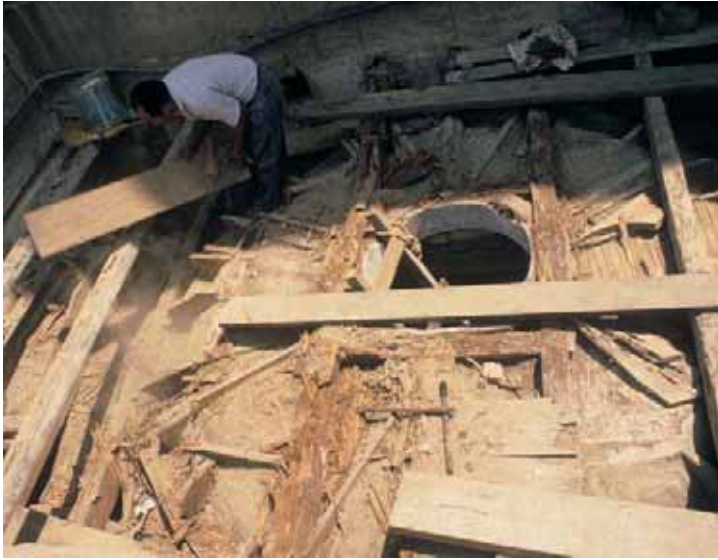
Retiro de elementos deteriorados en estructura de cubierta
