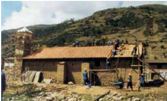
Capilla en proceso de la restauración
