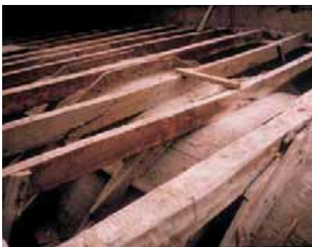
Intervención estructural en bóveda
