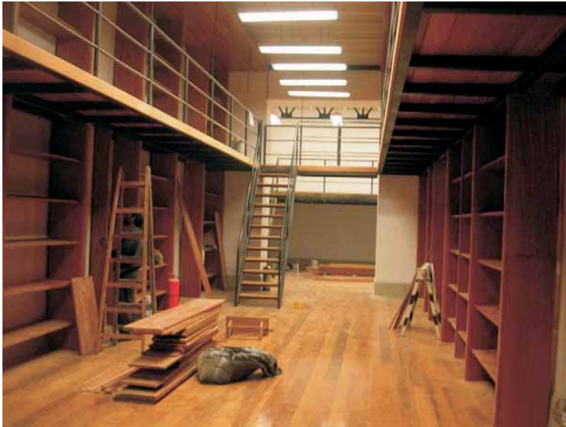
[ 1, 2, 3 ] Proceso de intervención de la biblioteca
