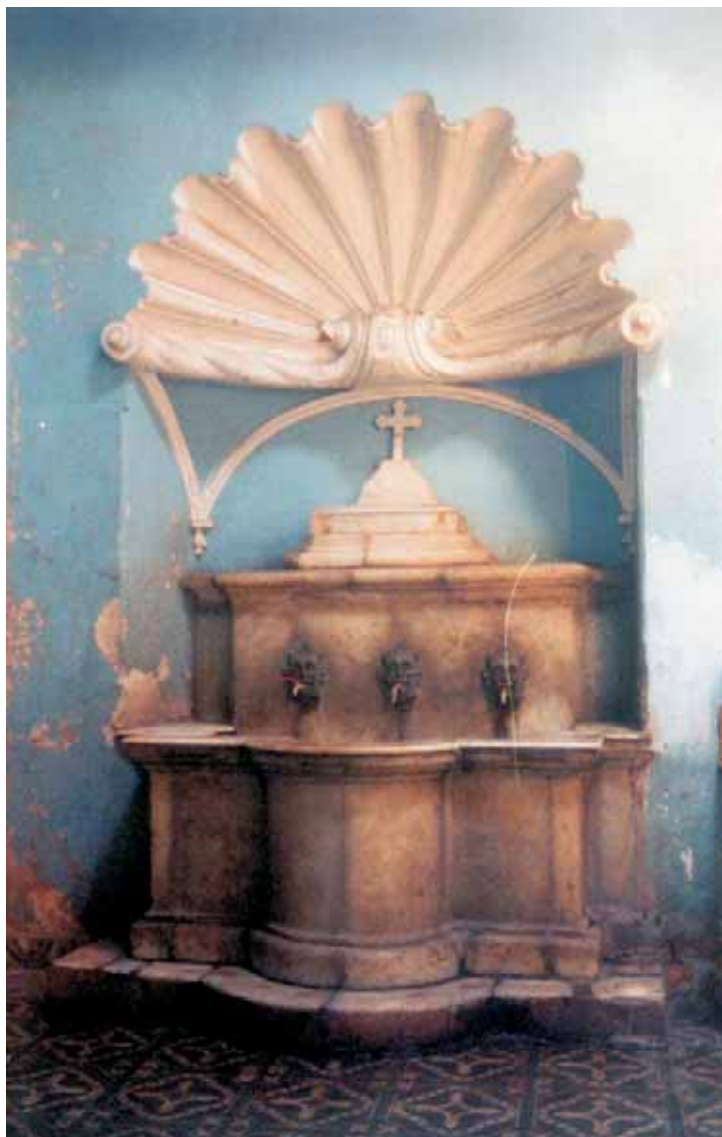
Lavatorio antes de la intervención
