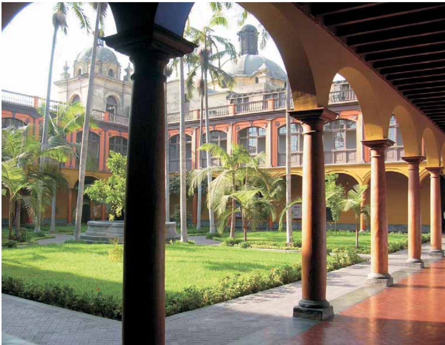
Patio de Letras restaurado
