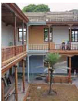
Proceso de intervención
