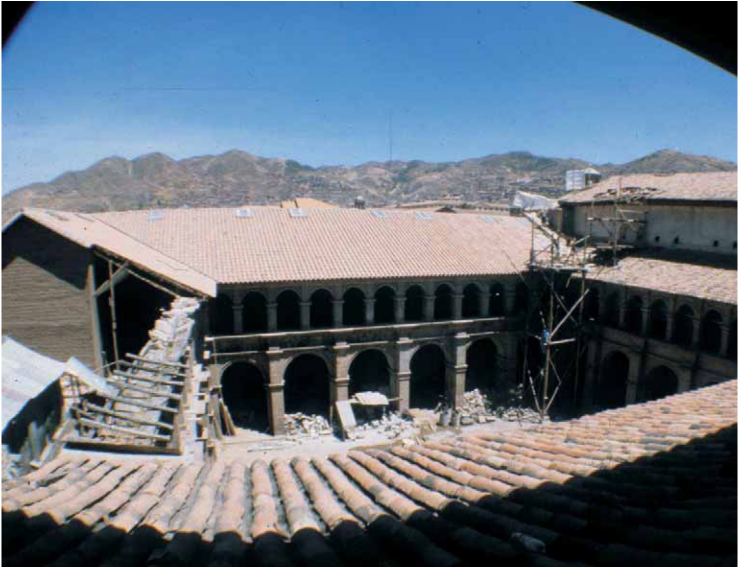
Proceso de intervención del segundo claustro
