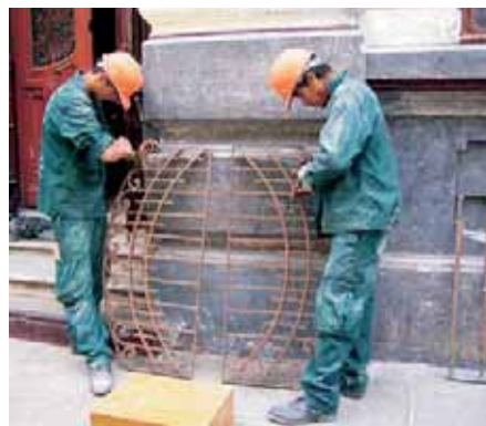
Limpieza de rejas
