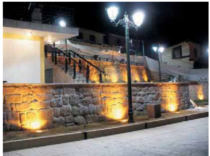
Estado actual del mirador
