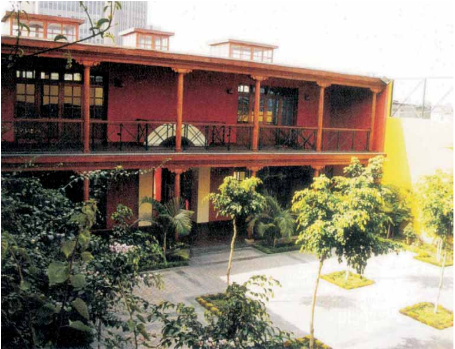
Antigua huerta rehabilitada
