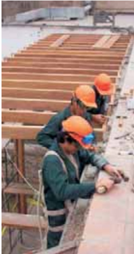
Colocación de viguetas
