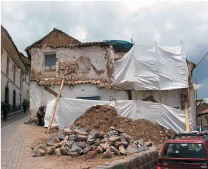
Inmueble antes de la intervención
