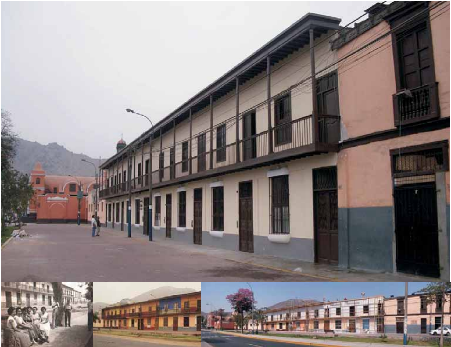
Fotografías del antes y después de la intervención a la casa del Balcón Corrido
