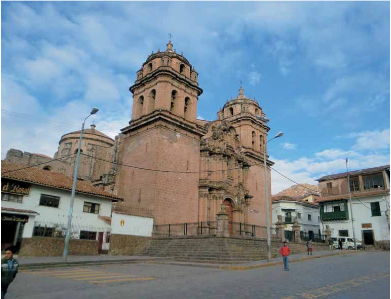
Vista exterior del templo
