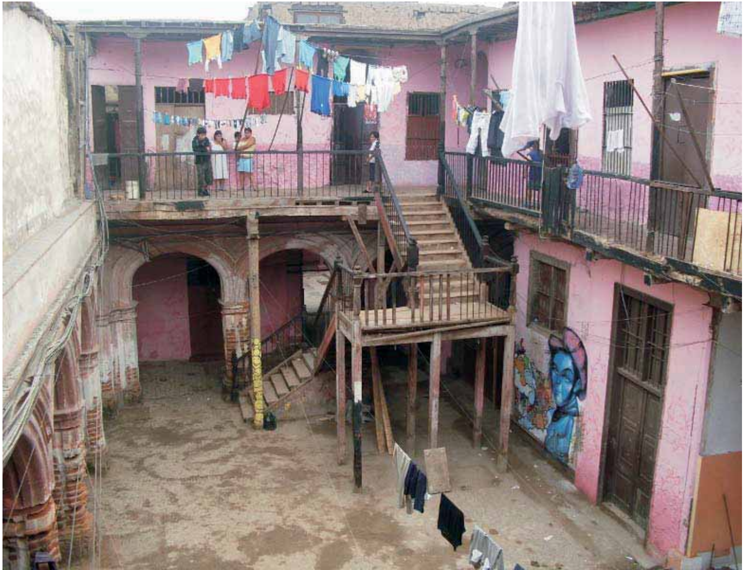
Inmueble tugurizado - Casa de la Columna
