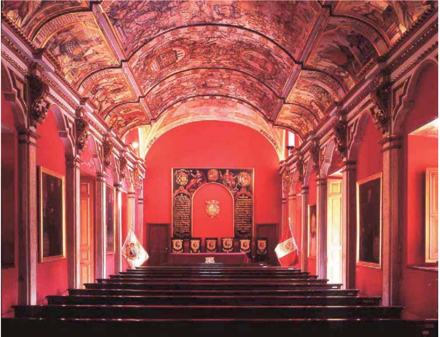
Salón de Grados restaurado
