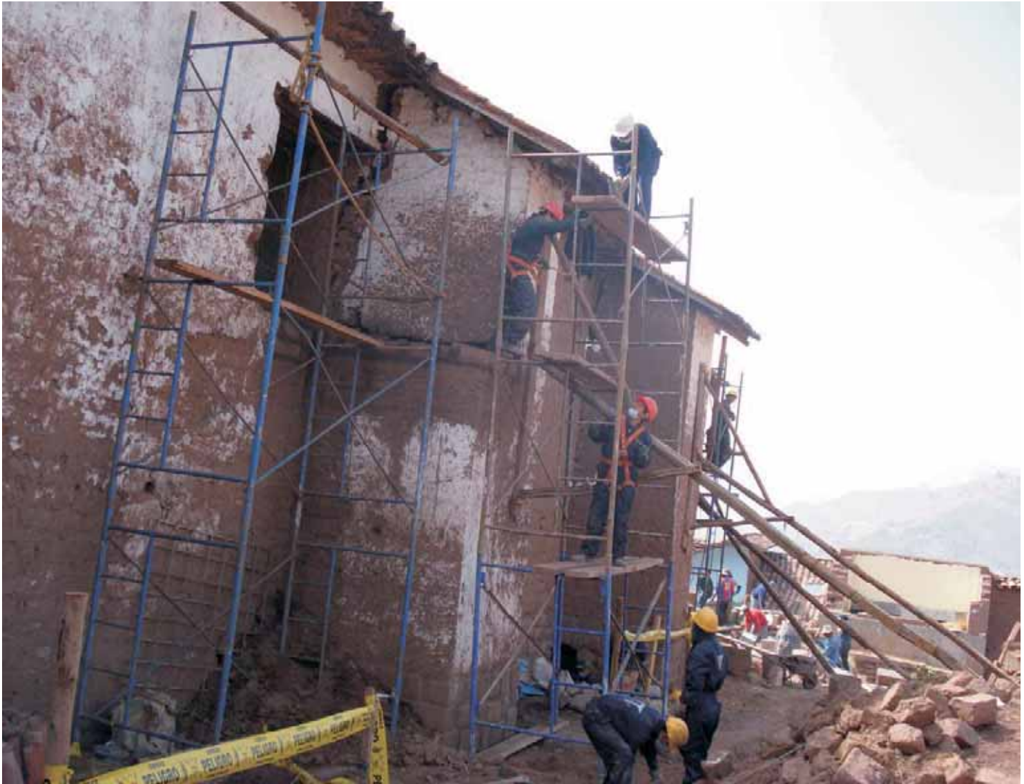
Refacción de muros exteriores
