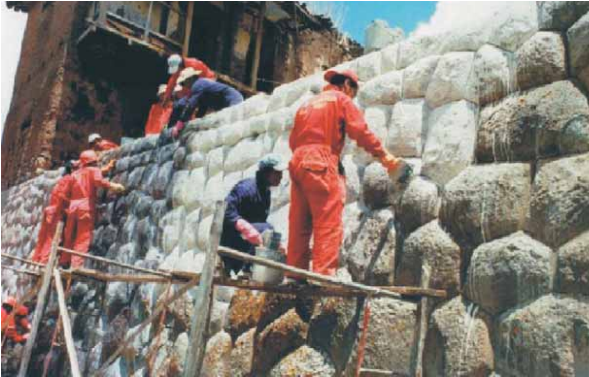
[ 1, 2 ] Proceso de limpieza de líquenes en muros de piedra
