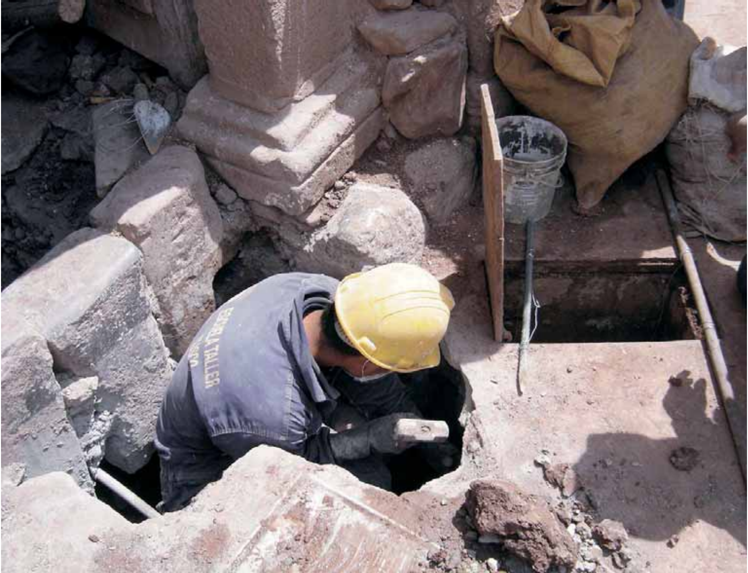
Conexión de redes de agua y desagüe
