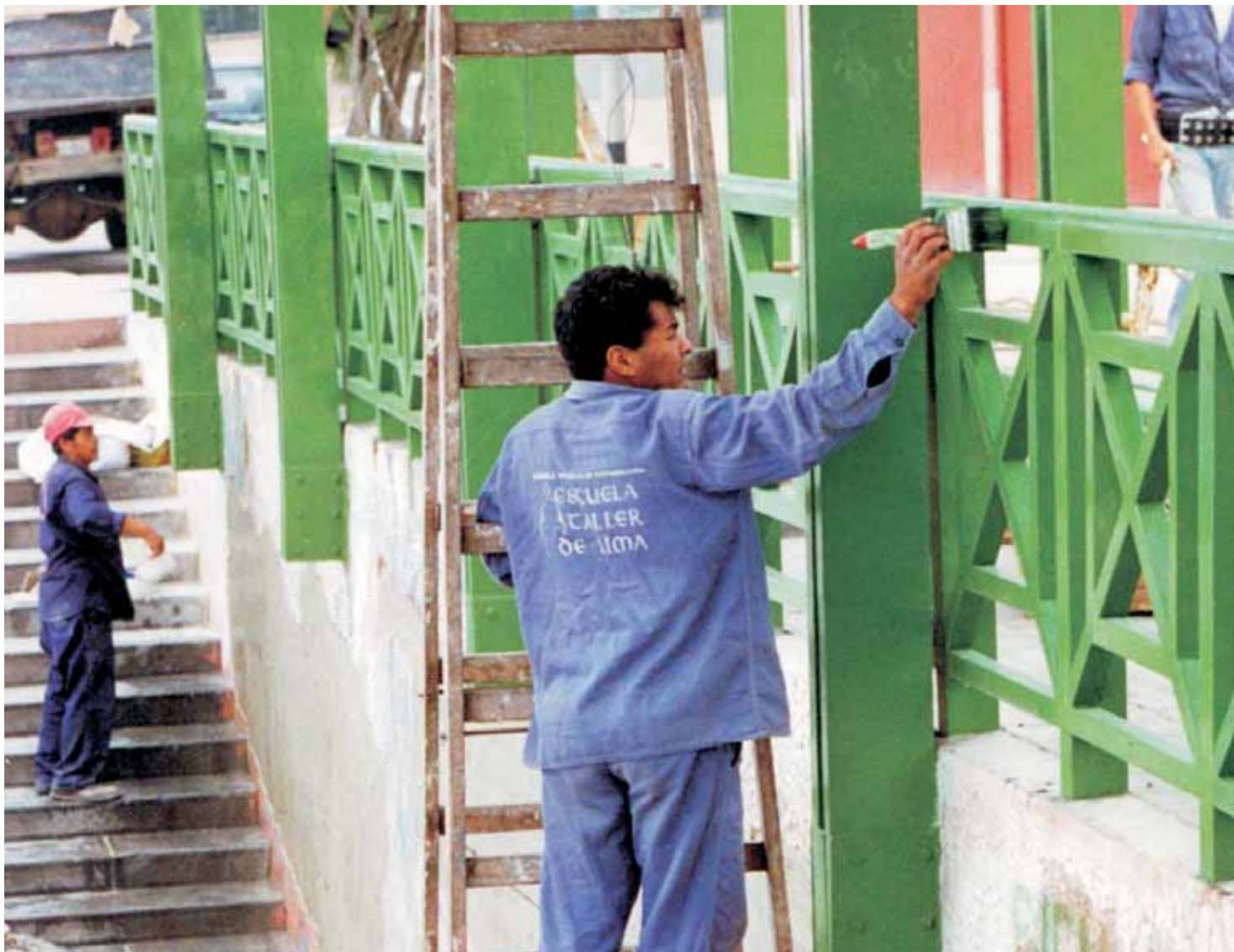
Trabajos de pintado del mirador
