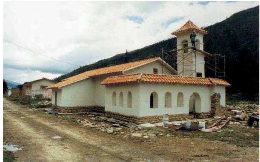
Capilla después de la intervención
