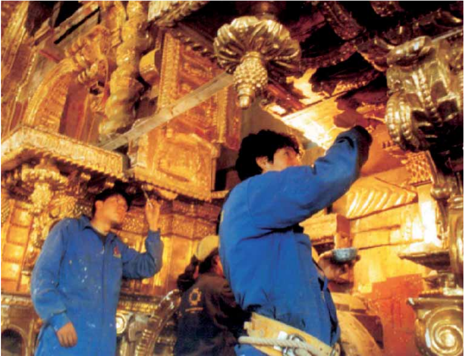
Trabajos de conservación de retablos
