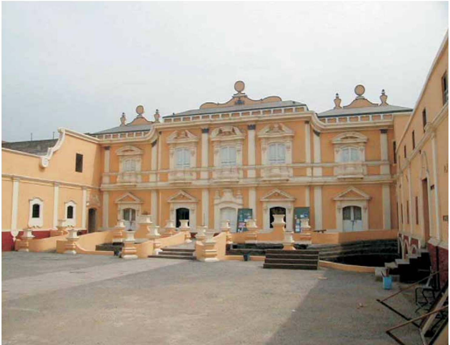
Quinta de Presa después de la intervención - 1994
