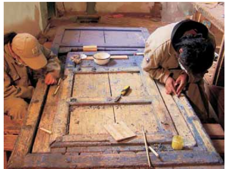
Tratamiento de puertas
