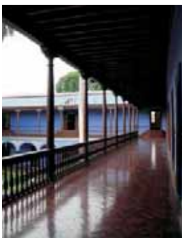
Galería del segundo nivel restaurada
