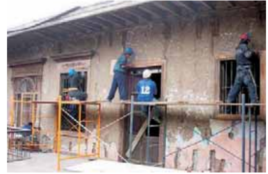
Trabajos de carpintería
