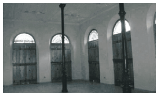
Estado del centro cultural antes de su intervención
