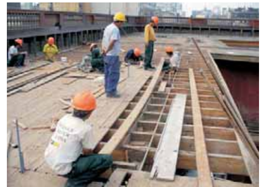
Colocación de entablado
