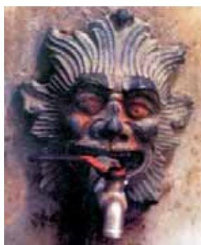
Caño antes de la intervención
