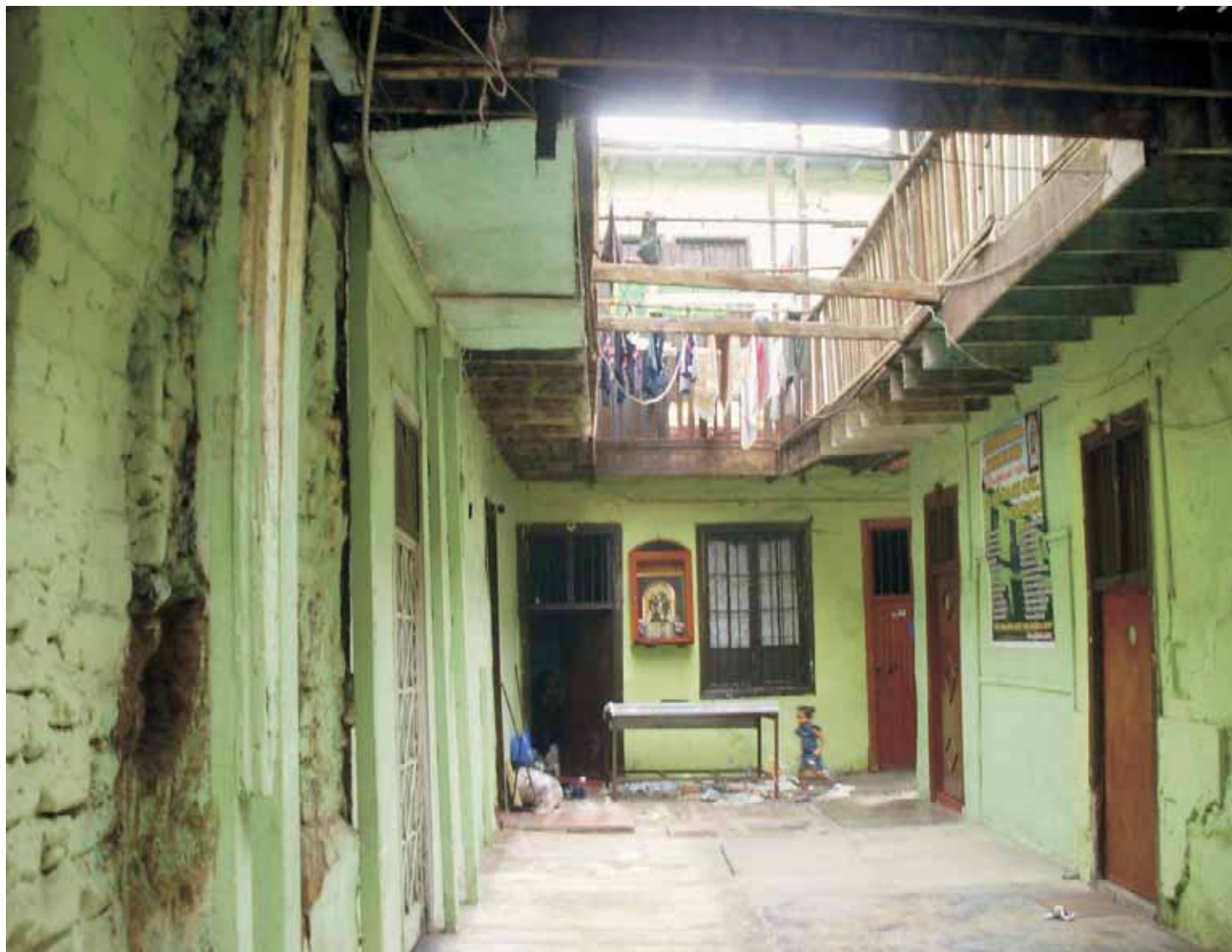
Quinta Jr. Libertad antes de la intervención
