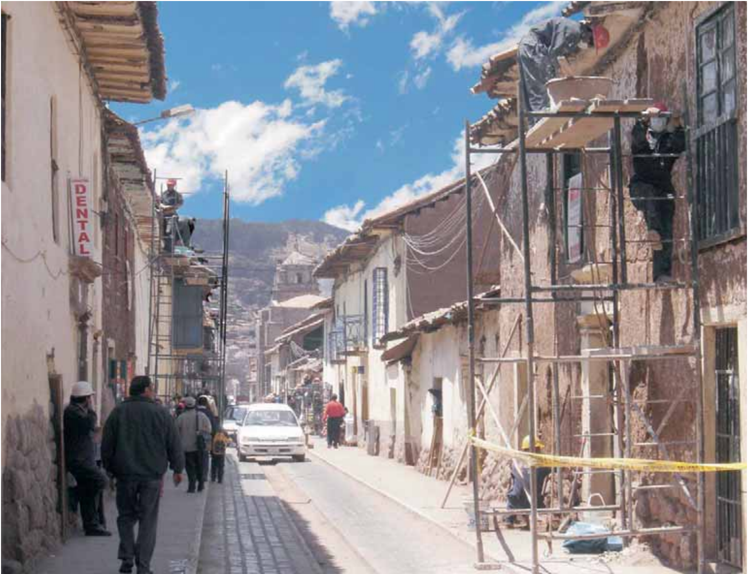
Trabajos de mejoramiento de fachadas
