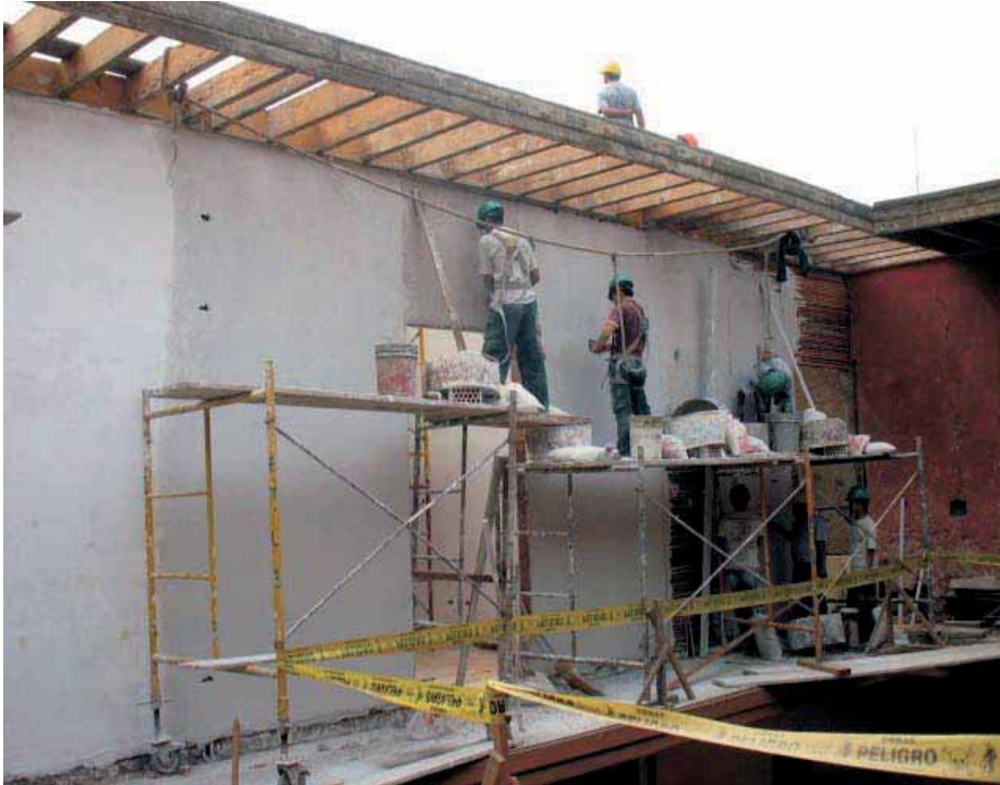
Trabajos de resane en muros
