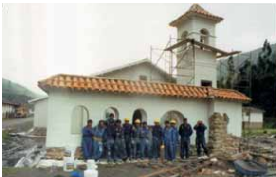
Capilla después de la restauración
