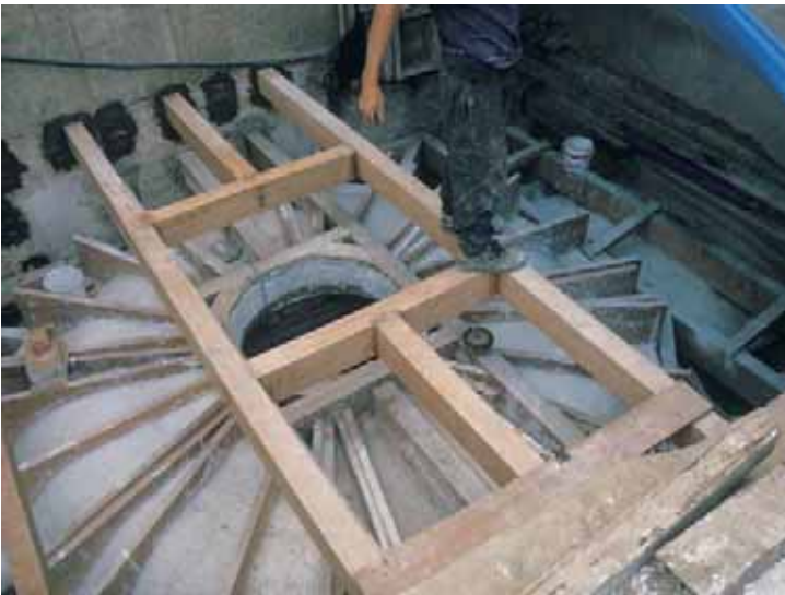
Sustitución de elementos deteriorados en estructura de cubierta
