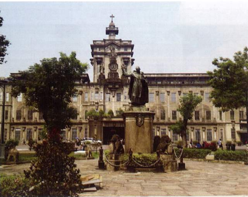
Edificio principal de UST construido por Fr. Roque Ruaño e inspirado en el Imperial Hotel (Tokio) de Frank Lloyd Wright.
