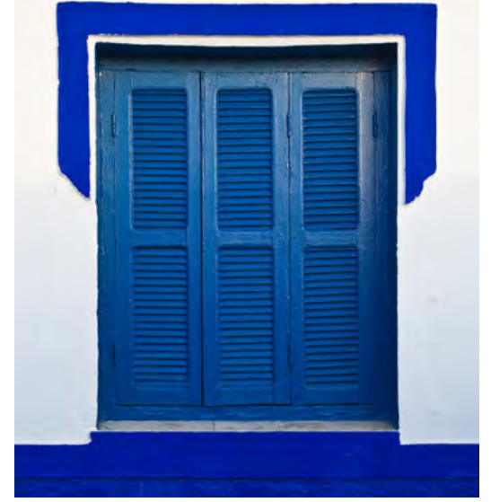
Detalle de suelo, pared y fachada.
