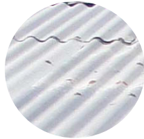
TECHO DE ZINC/ CALAMINA
