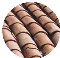
TECHO DE TEJAS
