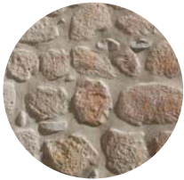
MURO DE PIEDRA
