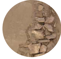
MURO DE LA MAMPOSTERÍA CUBIERTA EN YESO CHIVAY, SIBAYO
