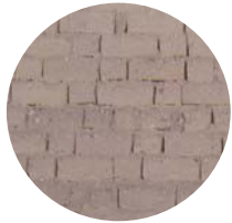
MURO DE ADOBE
