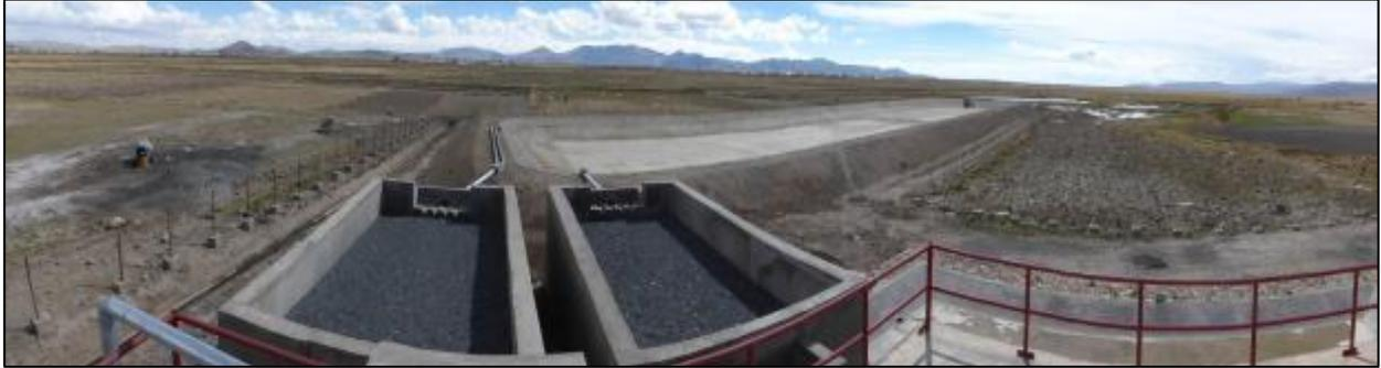
Filtros FAFA y laguna de maduración en PTAR del proyecto de alcantarillado sanitario, construidos en el proyecto de Warisata.
