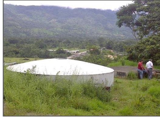
Fotografía 2: Tanque de reserva en desuso (en primer plano), tanque antiguo en uso con agua no tratada en segundo plano. Al fondo, la comunidad de Leónidas Proaño (Zamora-Chinchipec)
