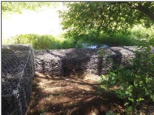
Fotografía 9: Muro gavionado en ribera laguna El Jocotal para protección de azolve por erosión
