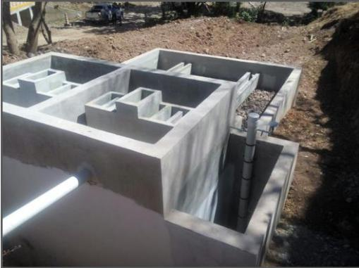
Fotografía 1: Planta de Tratamiento Aguas Residuales "Construcción Alcantarillado del Casco Urbano de San Antonio del Norte"
