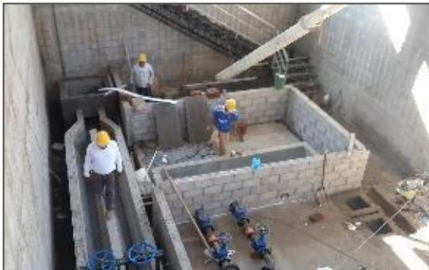
Fotografía 11: Construcción de Planta de rebombeo de las aguas residuales. Proyecto Santa María I y II
