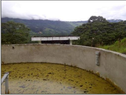
Fotografía 1: Filtro lento de arena en desuso con caseta de cloración en segundo plano, sistema San Pedro (Zamora-Chinchipec)
