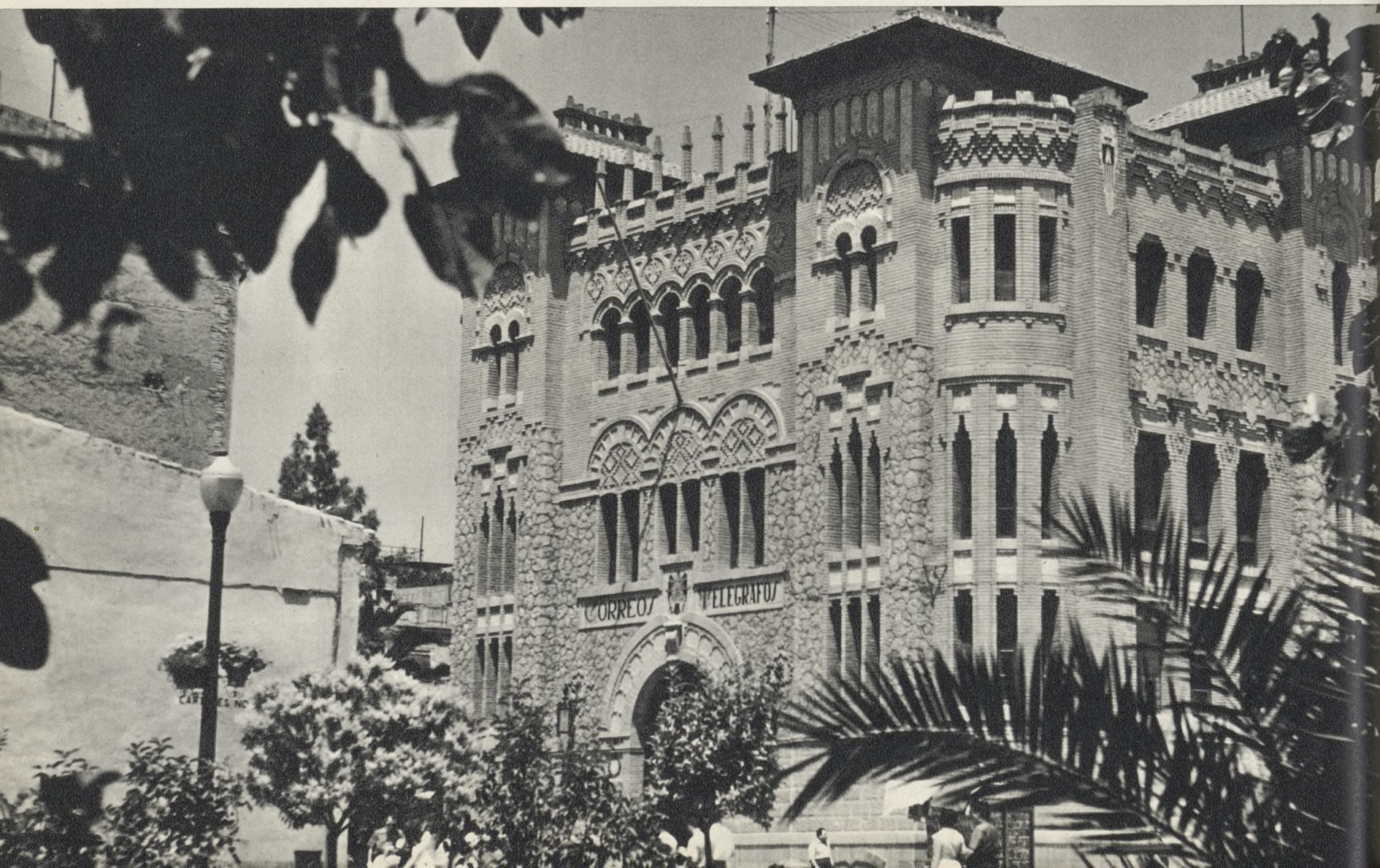
El Palacio de Comunicaciones en la capital.
