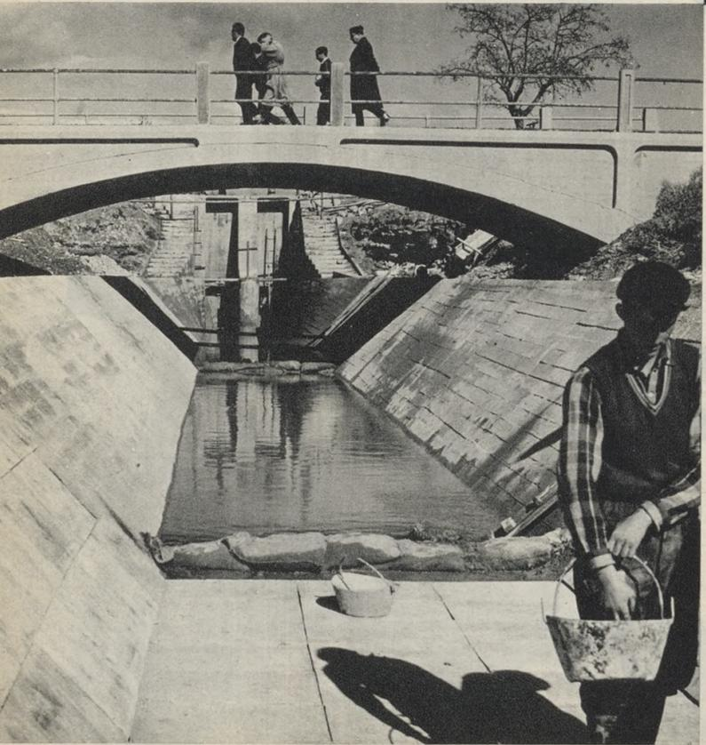
Obras de revestimiento de las paredes laterales y la solera del canal de La Violada, que, partiendo de la margen derecha del canal de los Monegros, en su primer tramo, domina una zona de riegos de 7.700 hectáreas en los términos de Alcalá, Almodébar y Gurra, en la provincia de Huesca, y Zuera y San Mateo, al norte de la de Zaragoza.
