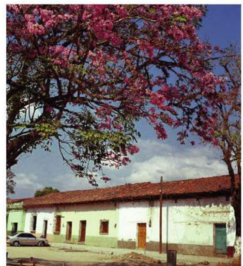
Obras en la rehabilitación del paseo La Alameda.
