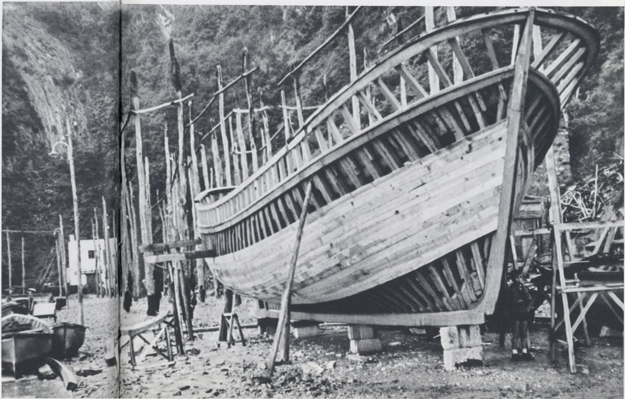
En este astillero de Cudillero se construyen barcos para la pesca del bonito.
