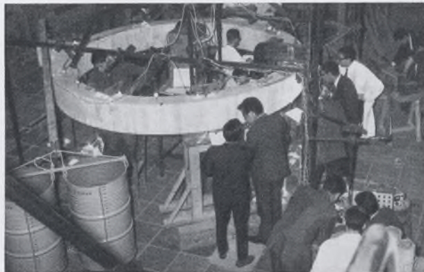
Ensayo de estructura anular en hormigón armado.
