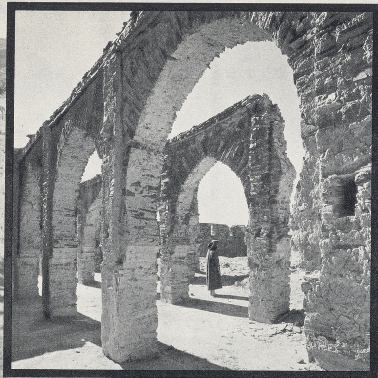
Ruinas y oasis de Smara.
