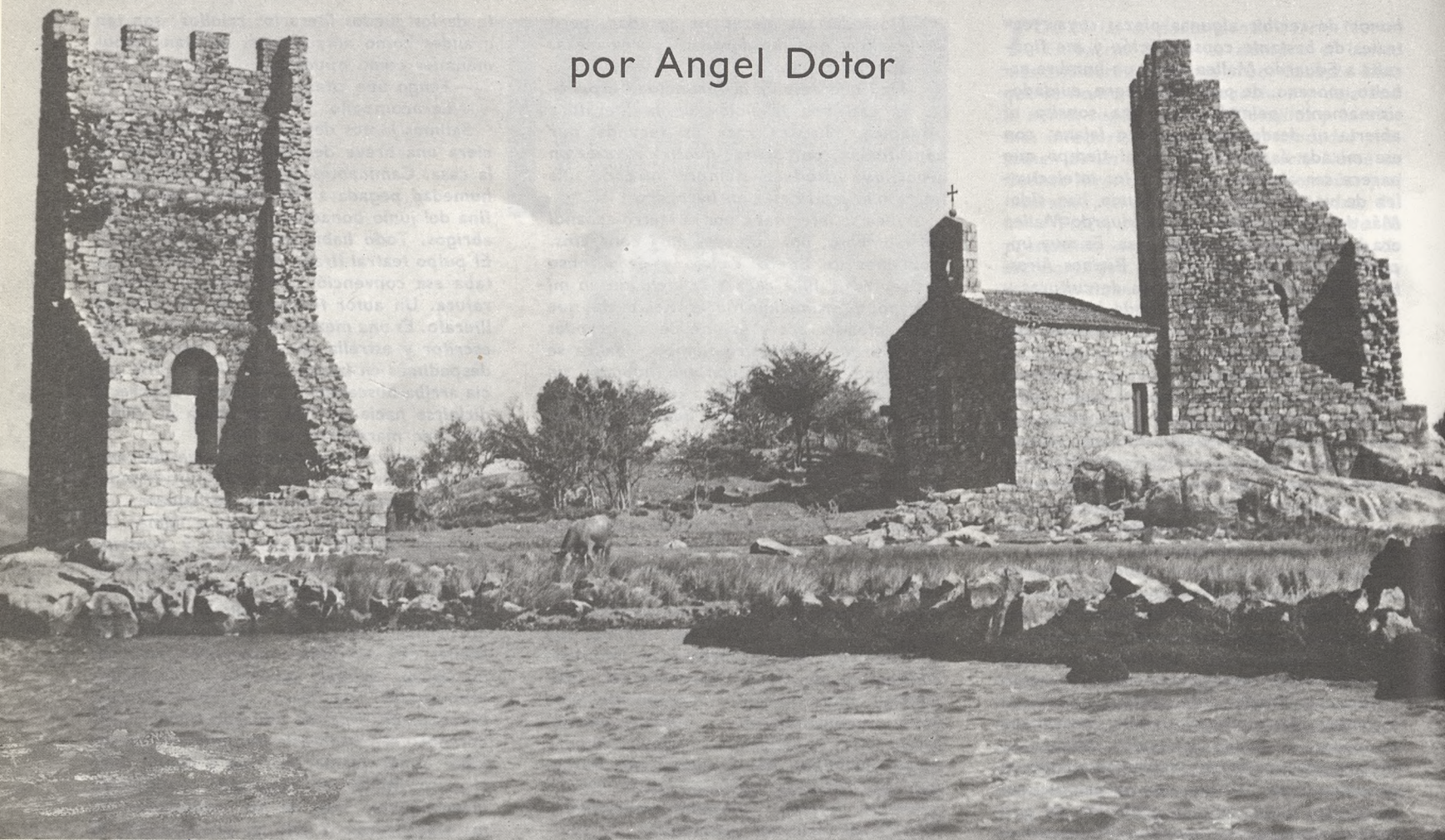
Vista panorámica de las Torres del Oeste.
