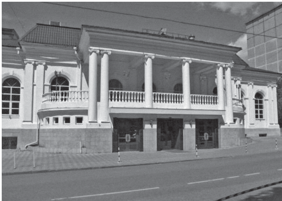
Edificio del Club Chkállov de Moscú
