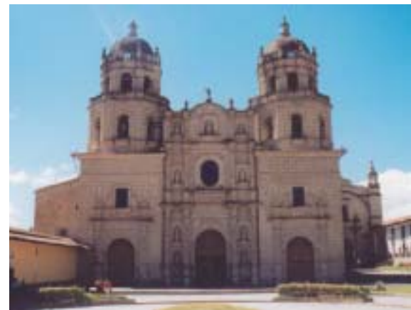
Iglesia de San Francisco, construida entre 1699 y 1737. Yolanda Rubatto
