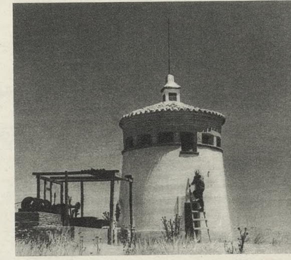
El depósito de aguas de Bernuy. El encargado, Ernesto Colinfres, mecánico del pueblo, se dispone a arreglar una pequeña avería.
