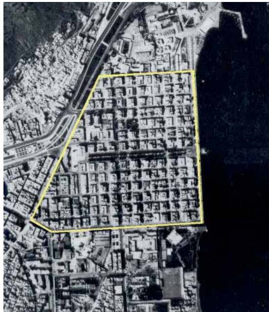
Vista área de la Cuadrícula de Nador en los años 90. Representa un centro urbano completamente edificado y una trama consolidada que contrasta con la morfología de los sectores urbanos que la rodean. Referencia en Berriane y Hopfinger 1999.
