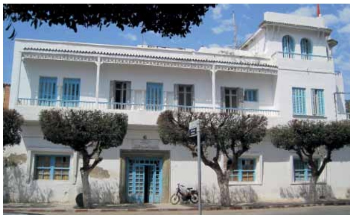
Edificio de la Junta de Servicios Municipales en la calle Muley Hasan Ben el Mehdí, Nador, 2005.
