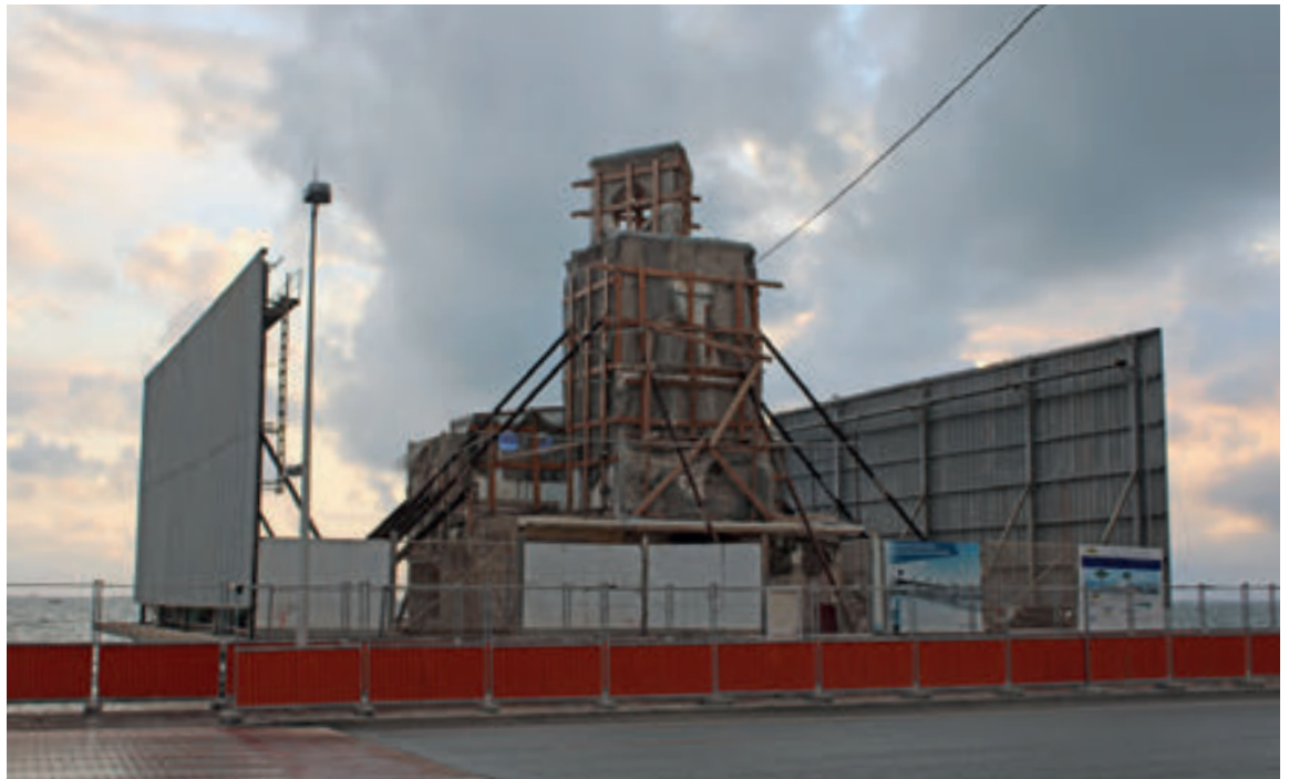
صورة حالية لمبنى النادي وهو قيد الترميم
