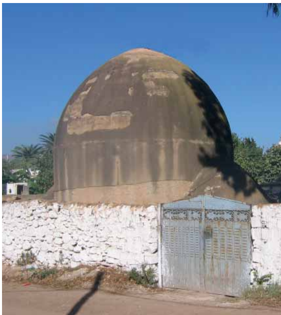
Abrigo de hormigón armado, cuartel de aviación, Nador, vista 2006.
