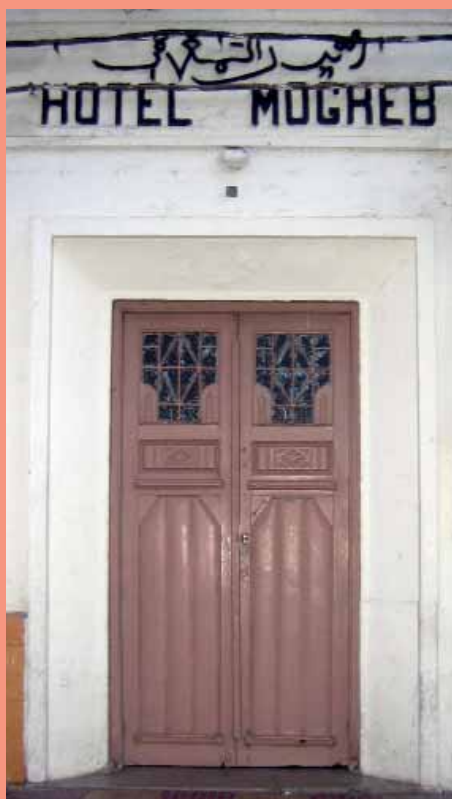
Puerta art déco, Avenida Youssef Ibn Tachafin, Hotel Mogreb, Nador.
