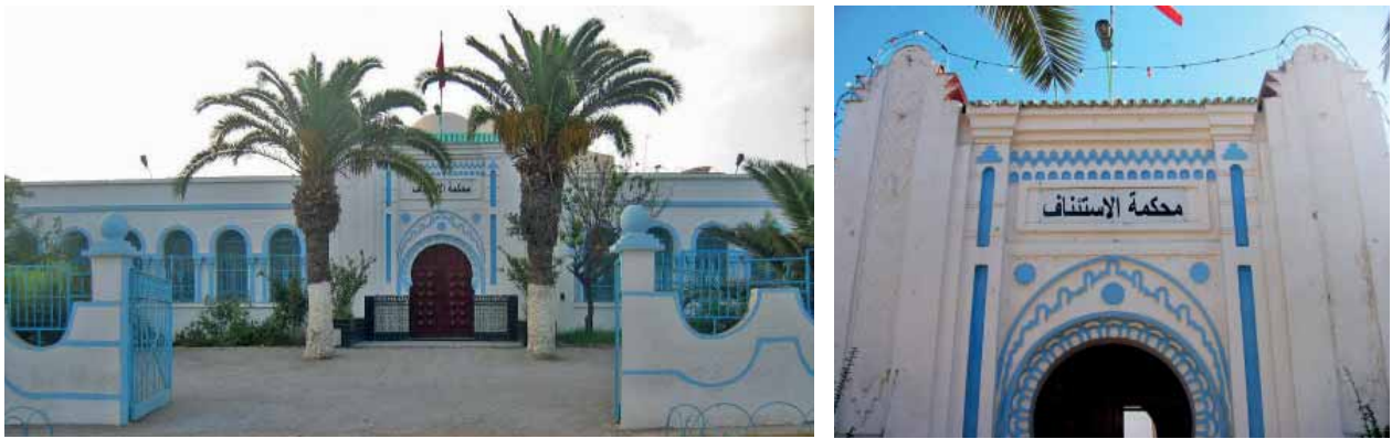
El edificio en los primeros años del siglo actual.
