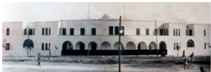
Fachada trasera del edificio.
