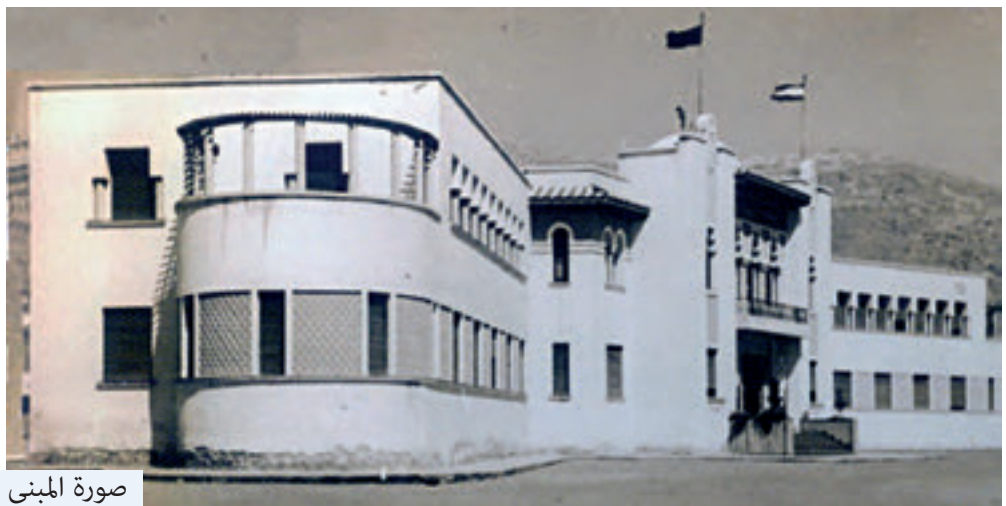
صورة المبنى في سنة 2004 قبل أن يتم هدم الكتل الجانبية
