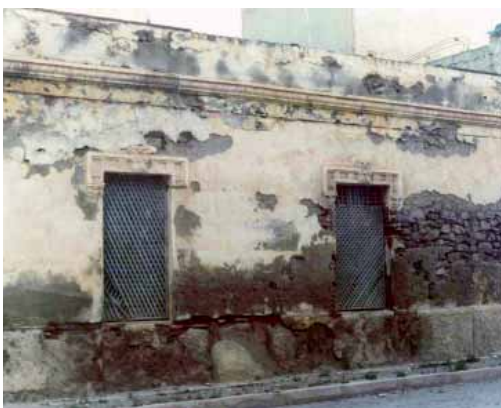
Edificio con molduras modernistas en las sobreventanas, Cuadrícula, calle Allal Ben Abdallah.
