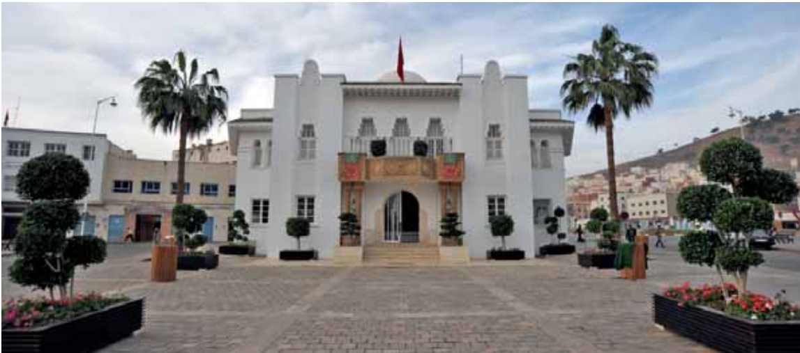
Estado actual del edificio.
