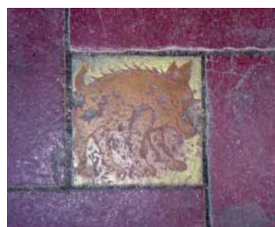
Azulejos del edificio de la Junta de Servicios Municipales en la calle Muley Hasan Ben el Mehdí, Nador, 2005.
