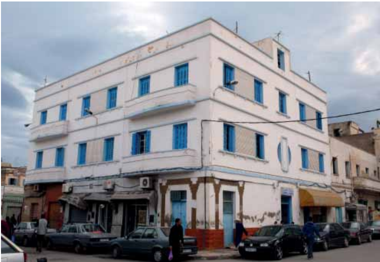
Edificio racionalista, calle General Mezziane, Nador, 2005.
