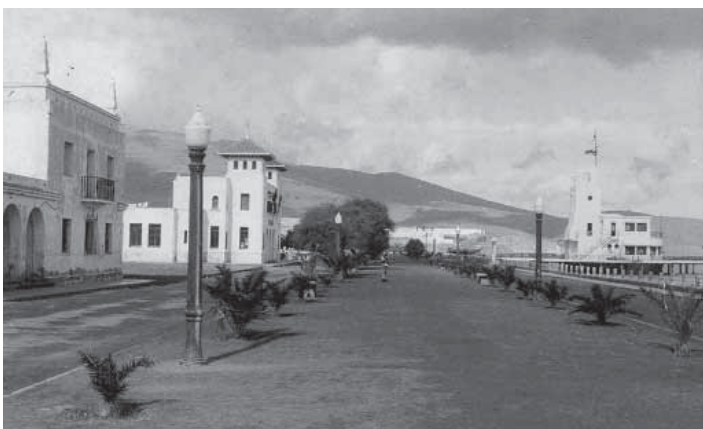
Pº Marítimo, vista de las viviendas para funcionarios y de Correos
