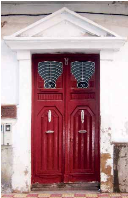
Puerta art déco, avenida Al-Jamia Al-Arabiya.
