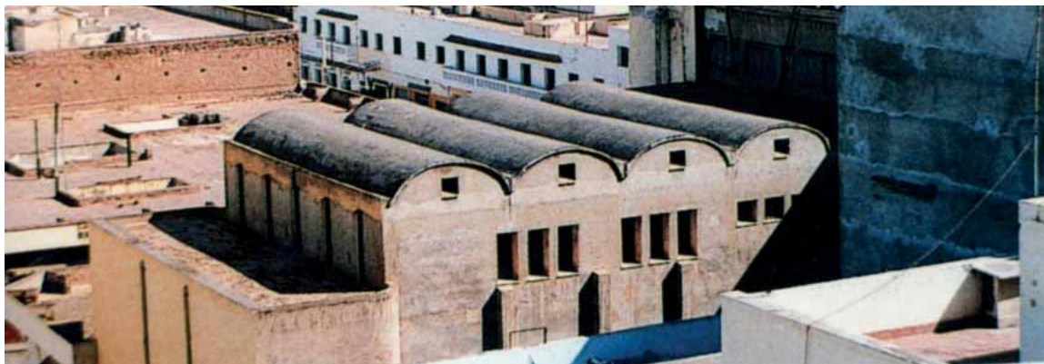
Vista de la cubierta del Cinema Rif.
