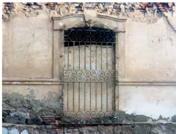
Edificio en la Cuadrícula de Nador, calle Ibn Khaldúm, detalle, 2005.
