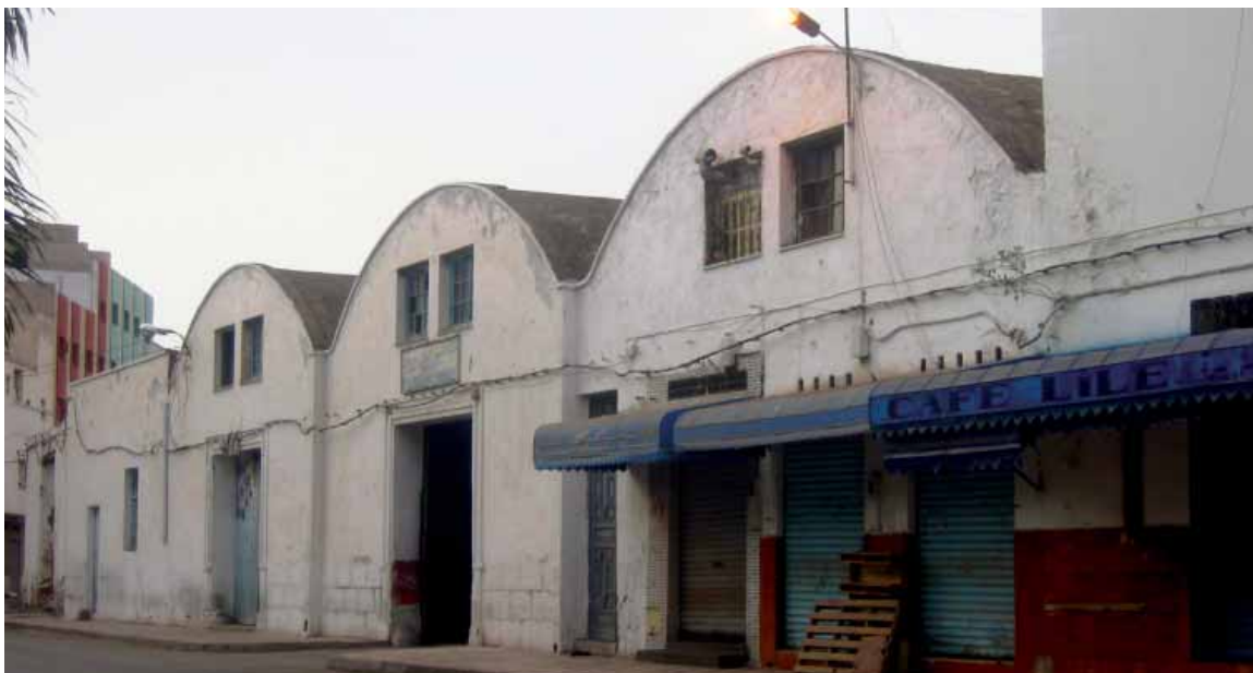
Cubiertas de hormigón armado en un edificio de Nador, actualmente destruido.
