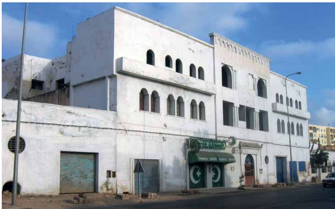
Edificio en la carretera a Melilla, vista actual.
