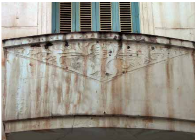
Detalle de los esgrafiados en sobreventana y en el cornisamento
