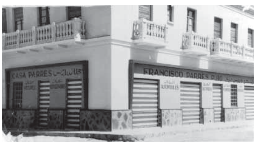
Fotografía de un edificio ya desaparecido, que muestra en su planta primera los característicos balcones modernistas, con balaustres y decoración floral. Hacia 1950.
