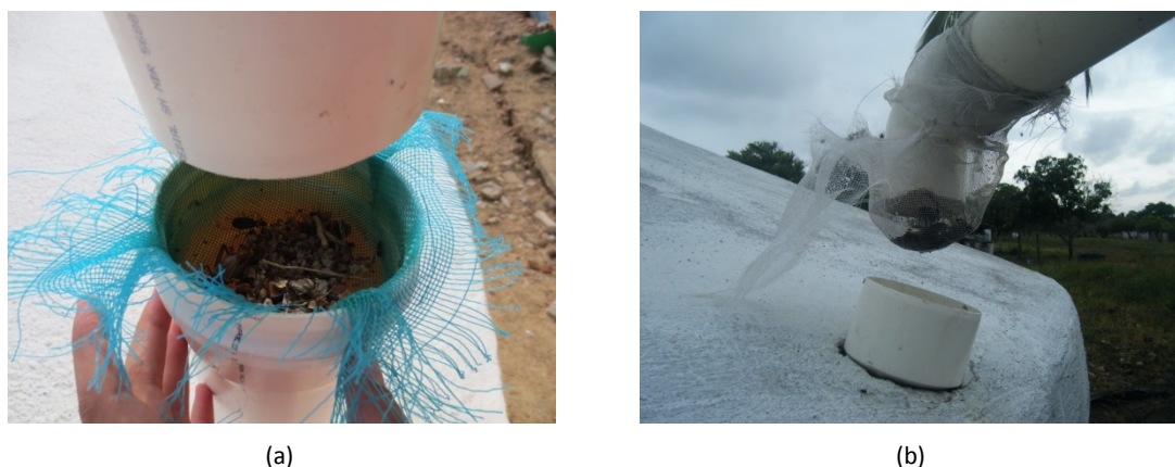
Figura 22. Fotos de las dos redes o mayas de las cisternas CONDRI después de las lluvias.
