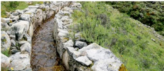
Canales de infiltración
