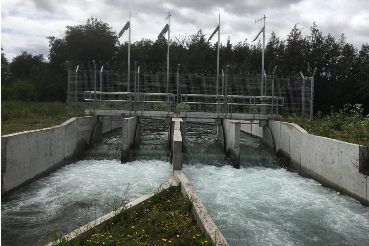
Un sistema moderno de distribución de agua usando compuertas automáticas.
